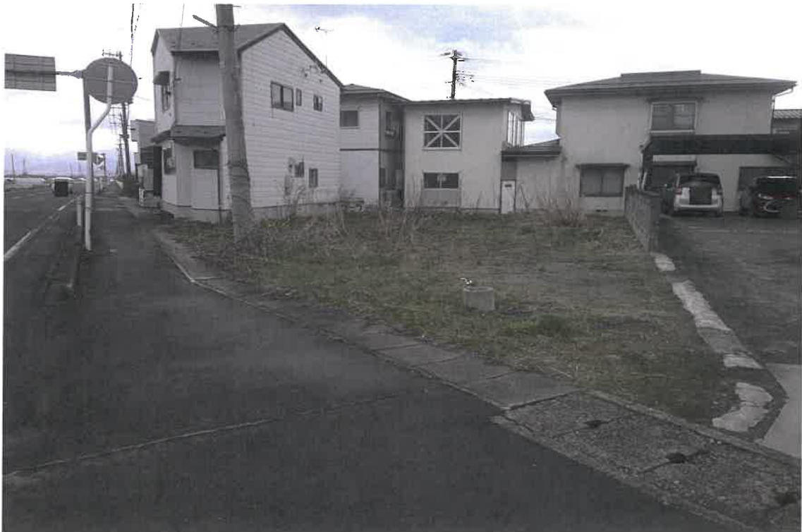
写真①(物件1 前面接道付近から外観撮影)
