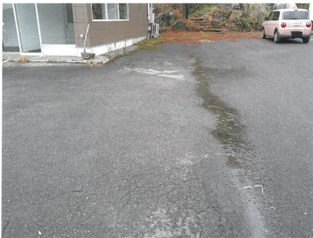
写真② (物件 1 2764番2との境界付近)
