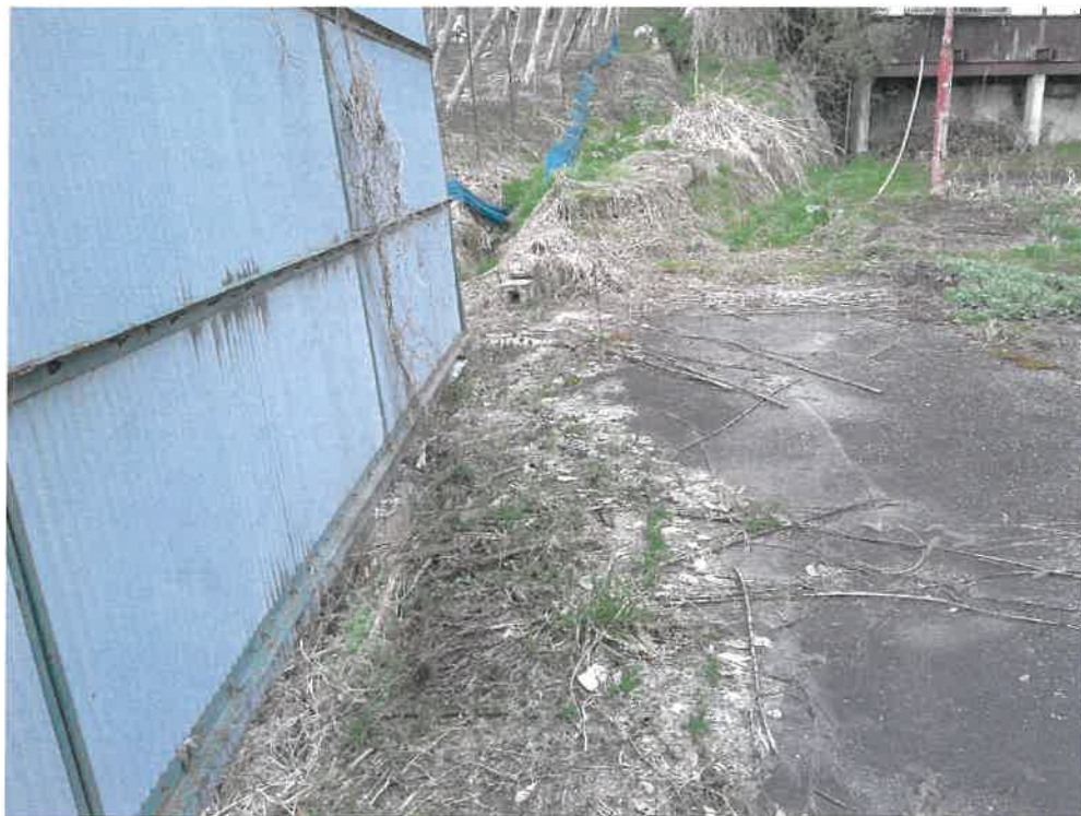
写真③ (物件 2 南側端部分の境界付近)
