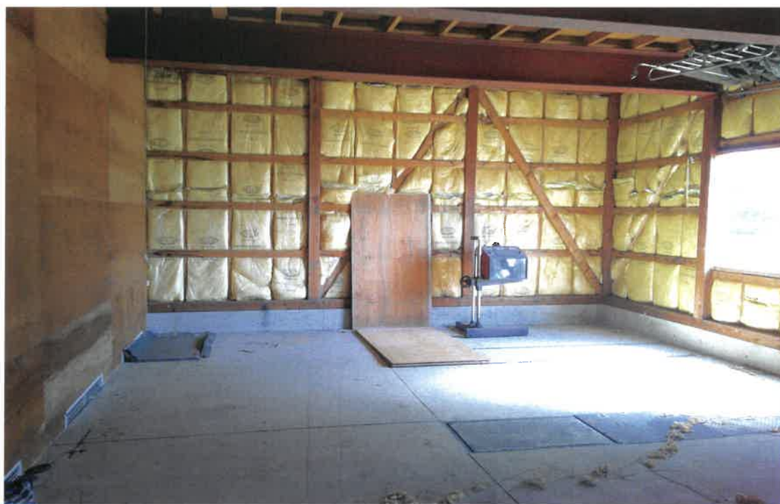
写真②(物件 8 1階 倉庫)
