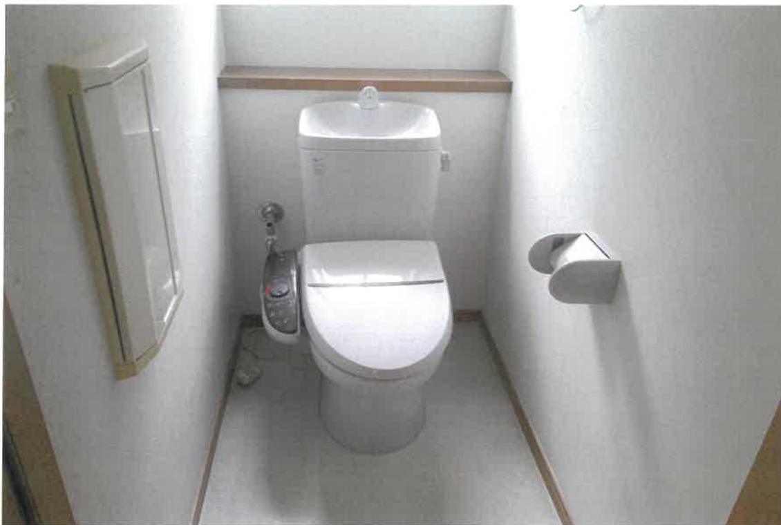
写真⑦(物件2 1階 トイレ)
