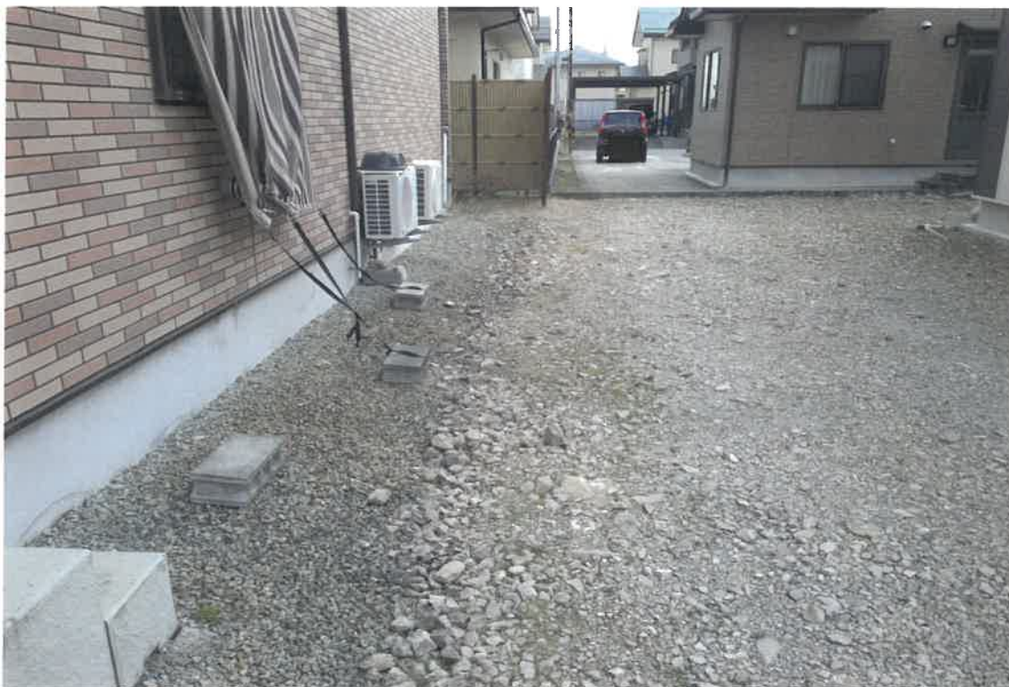
写真④(物件1 東側境界付近)
