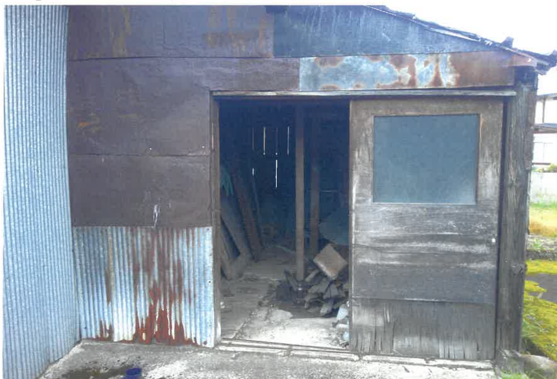
写真④(物件3 北側入口付近 )
