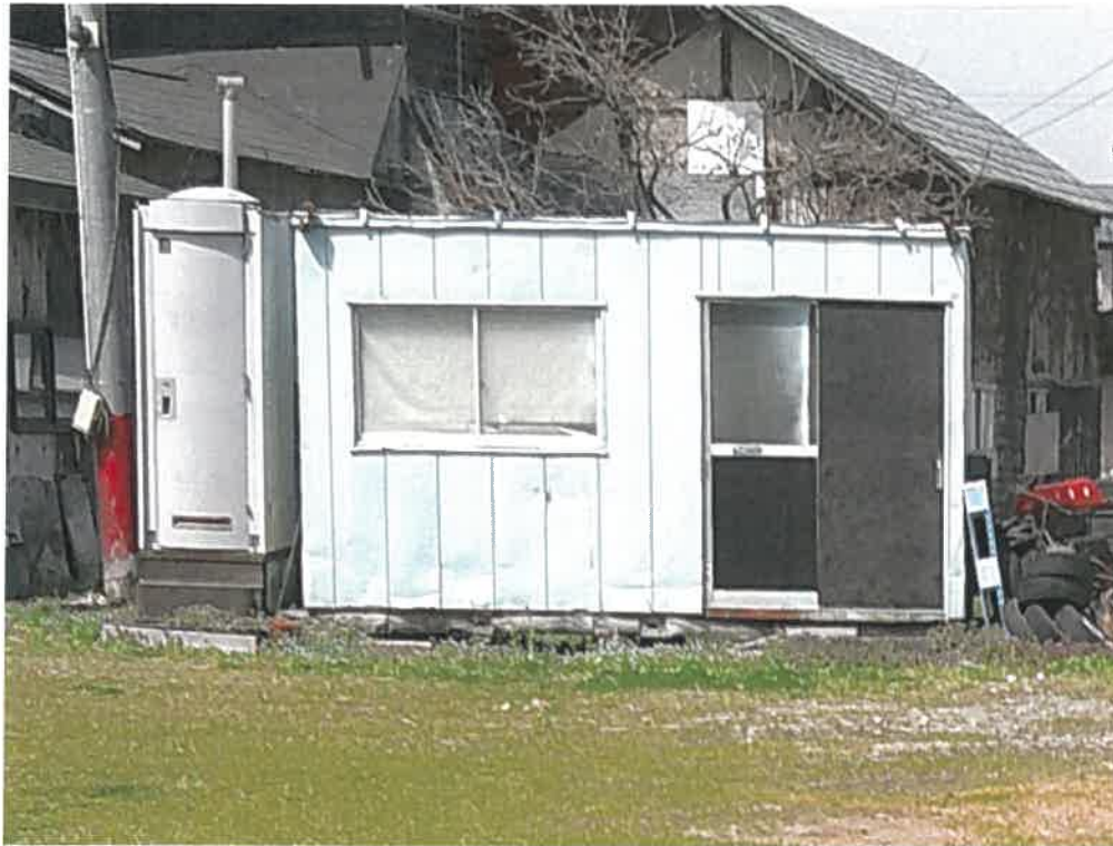
写真⑤ (物件 2 プレハブ物置と仮設便所)
