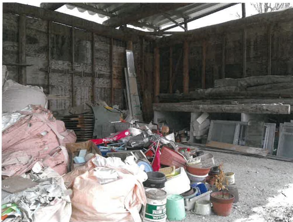
写真② (物件 4 建物内部)
