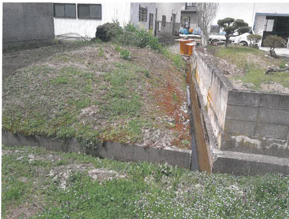
写真⑦ (物件 2 北側 境界付近)
