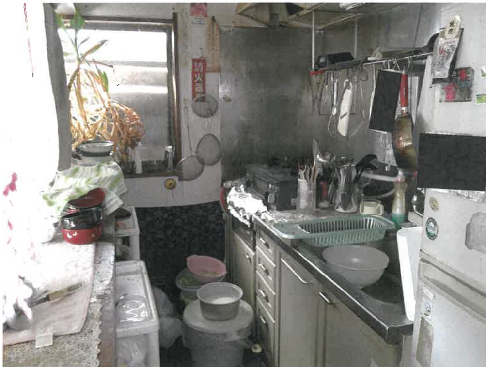
写真⑦ (物件2 1階 キッチン)
