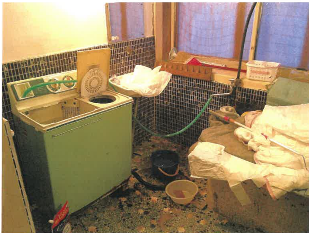
写真⑨ (物件2 1階 浴室)
