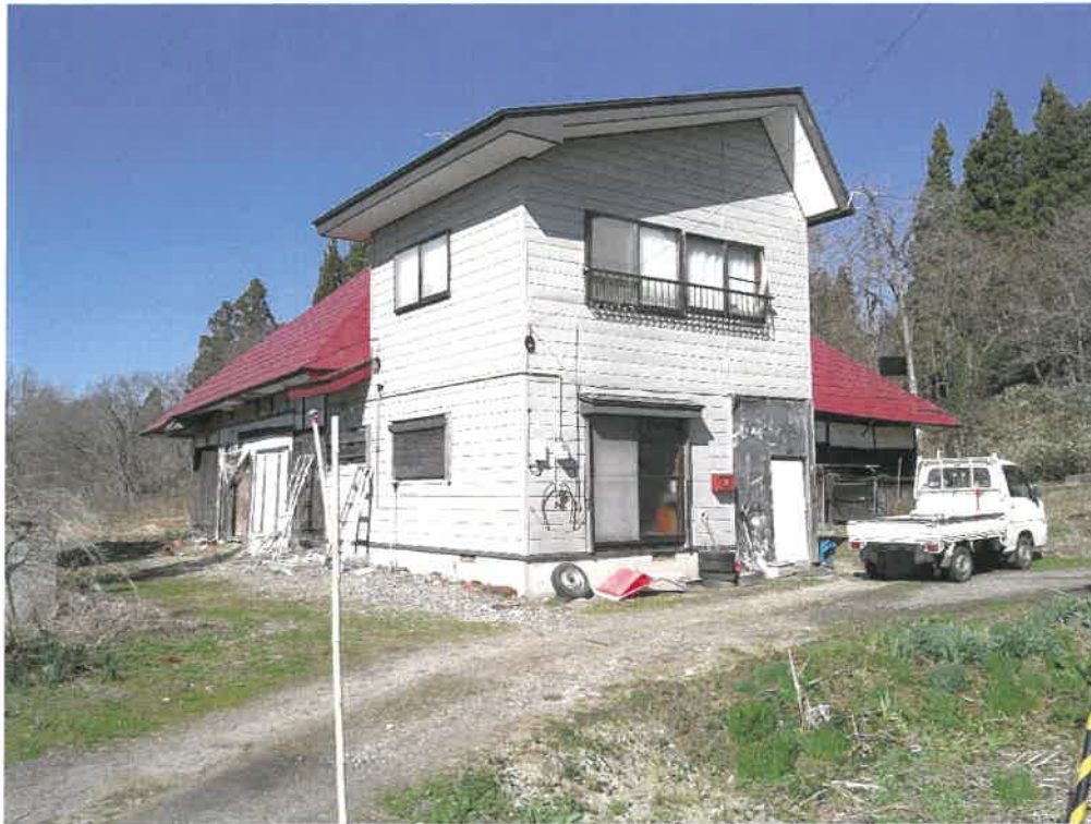
写真① (物件 2 建物外観 (主たる建物))
