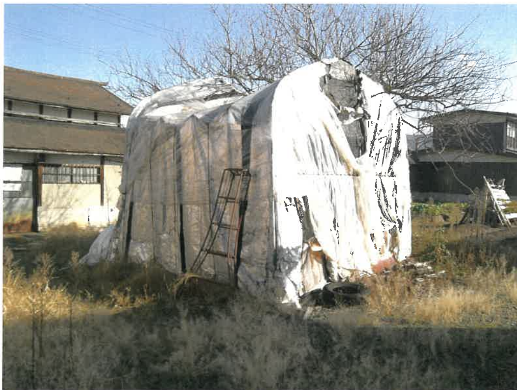
写真⑥(物件2 北東側 仮設テント)
