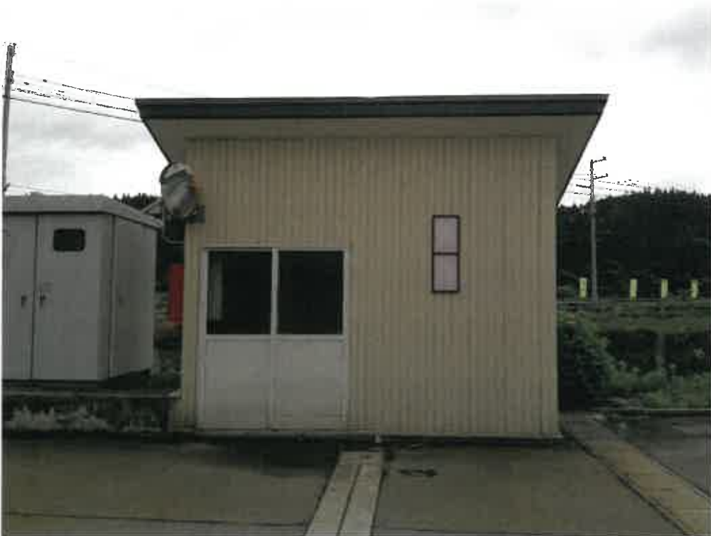
写真⑥ (物件 3 未登記附属建物 1)
