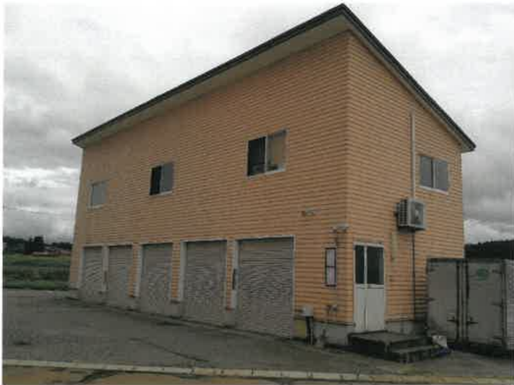
写真⑤ (物件 3 附属建物符号 1 建物外観)
