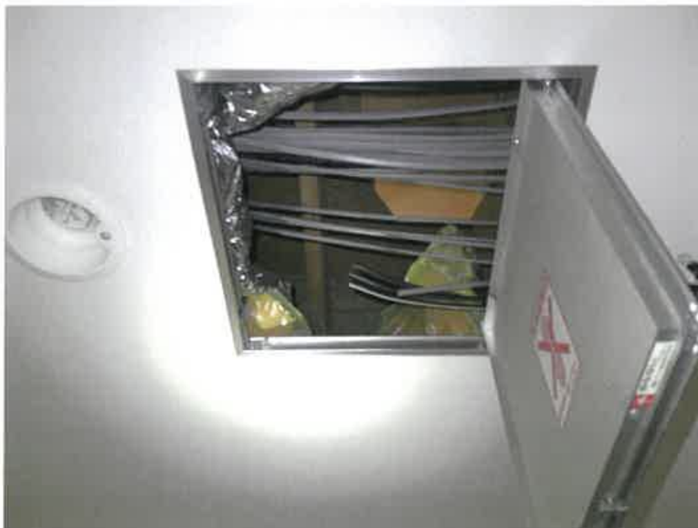
写真⑧(物件4 1階 フロア(天井))
