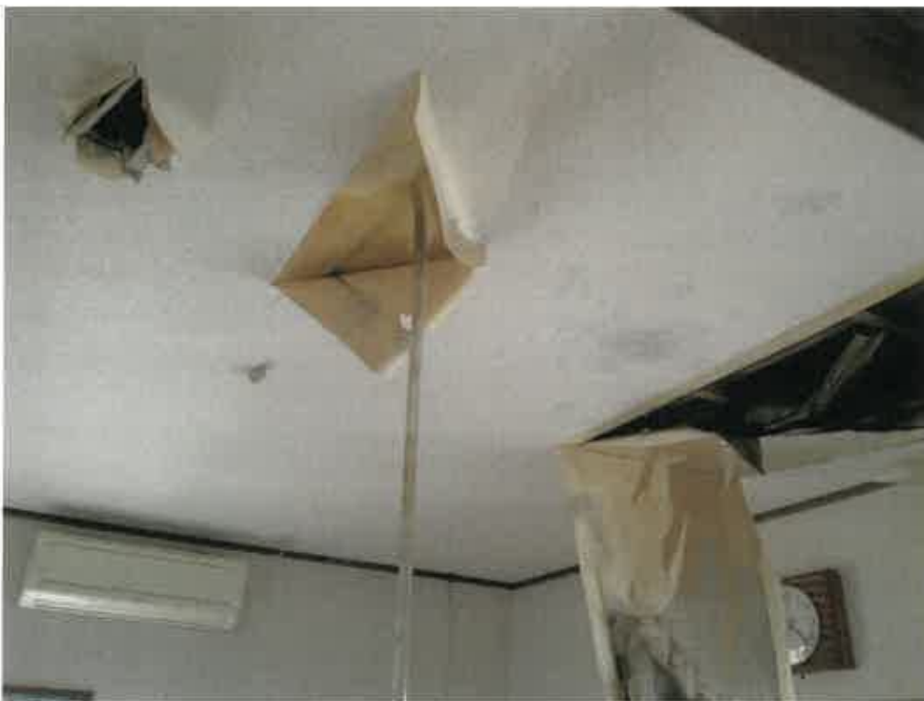
写真㉘(物件5 2階 洋室)
