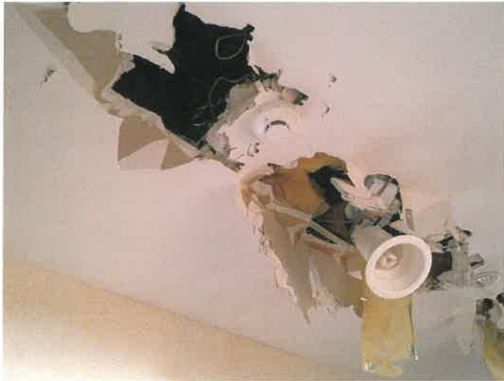
写真⑦(物件4 1階 フロア(天井))
