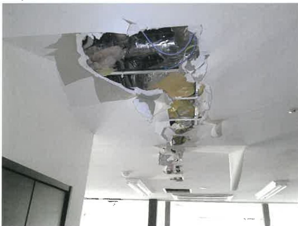
写真② (物件 4 1 階 (食堂・機能訓練室) 天井)
