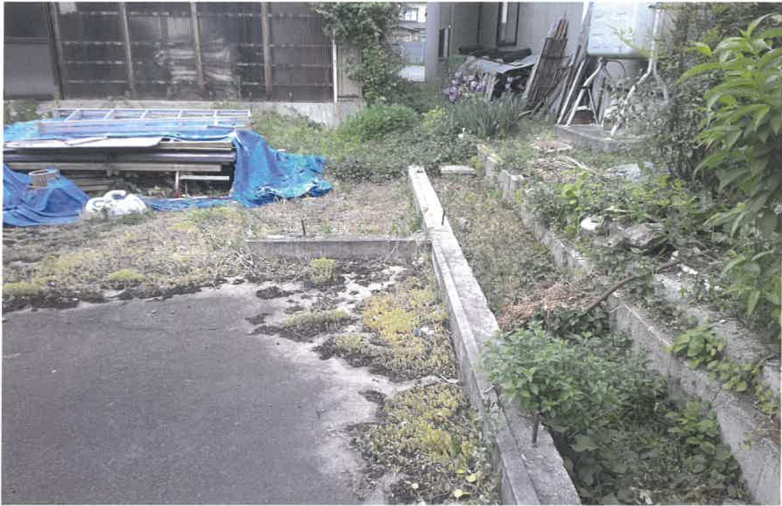
写真⑦(物件1 物件4の建物(滅失)基礎工事部分)
