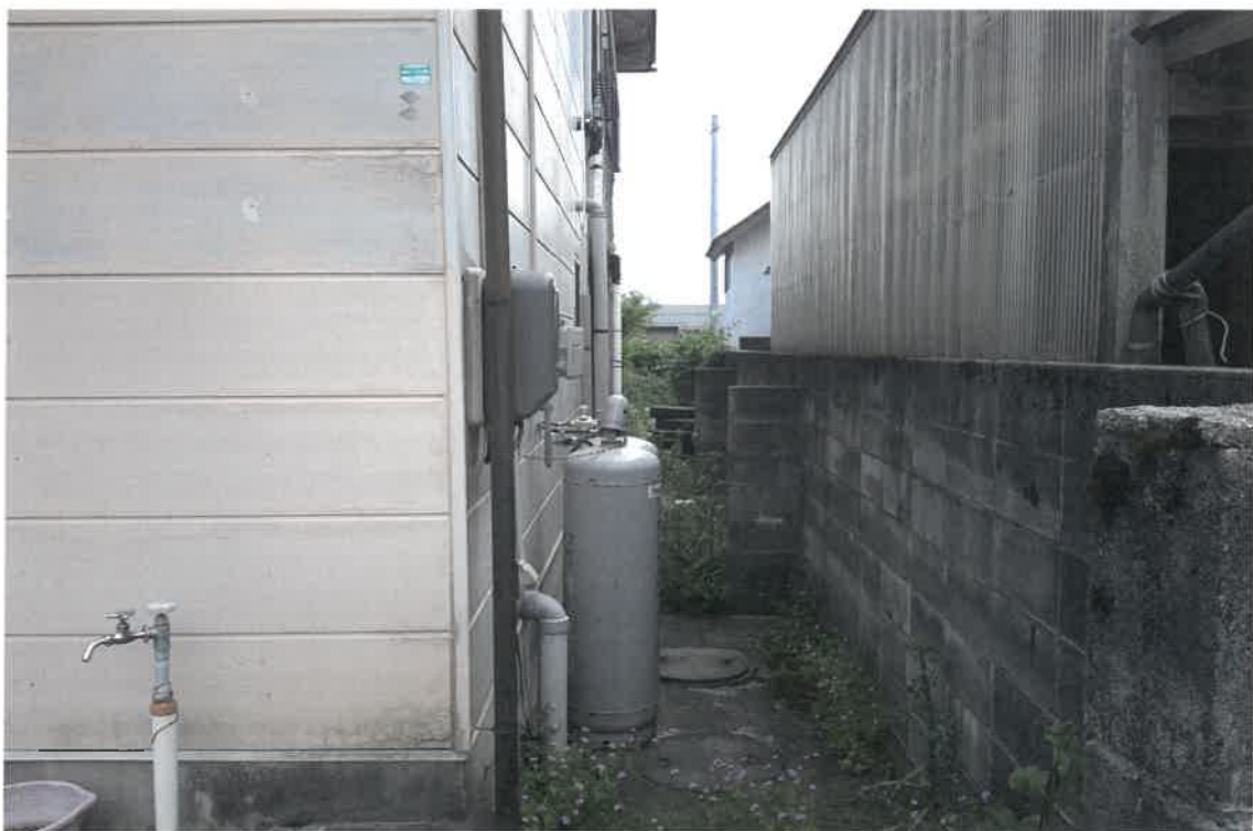
写真②(物件 1 西側境界付近)
