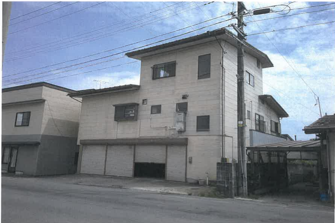
写真①(物件 3 建物外観及び接道付近)
