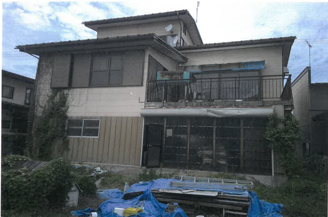
写真⑩(物件 3 南側から建物裏側外観)
