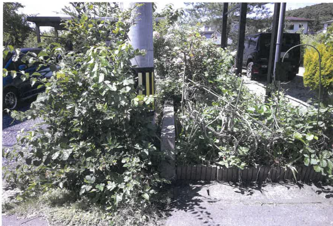
写真②(物件1 南東側境界付近)
