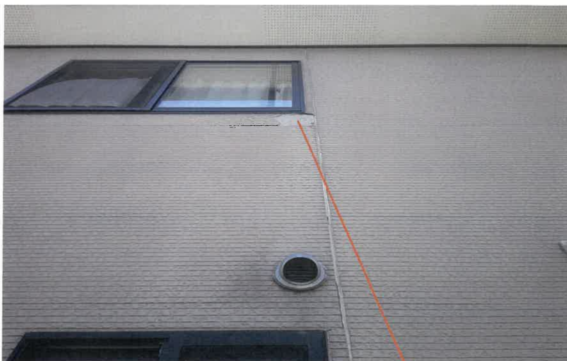
写真⑥(物件2 北西側外壁)
