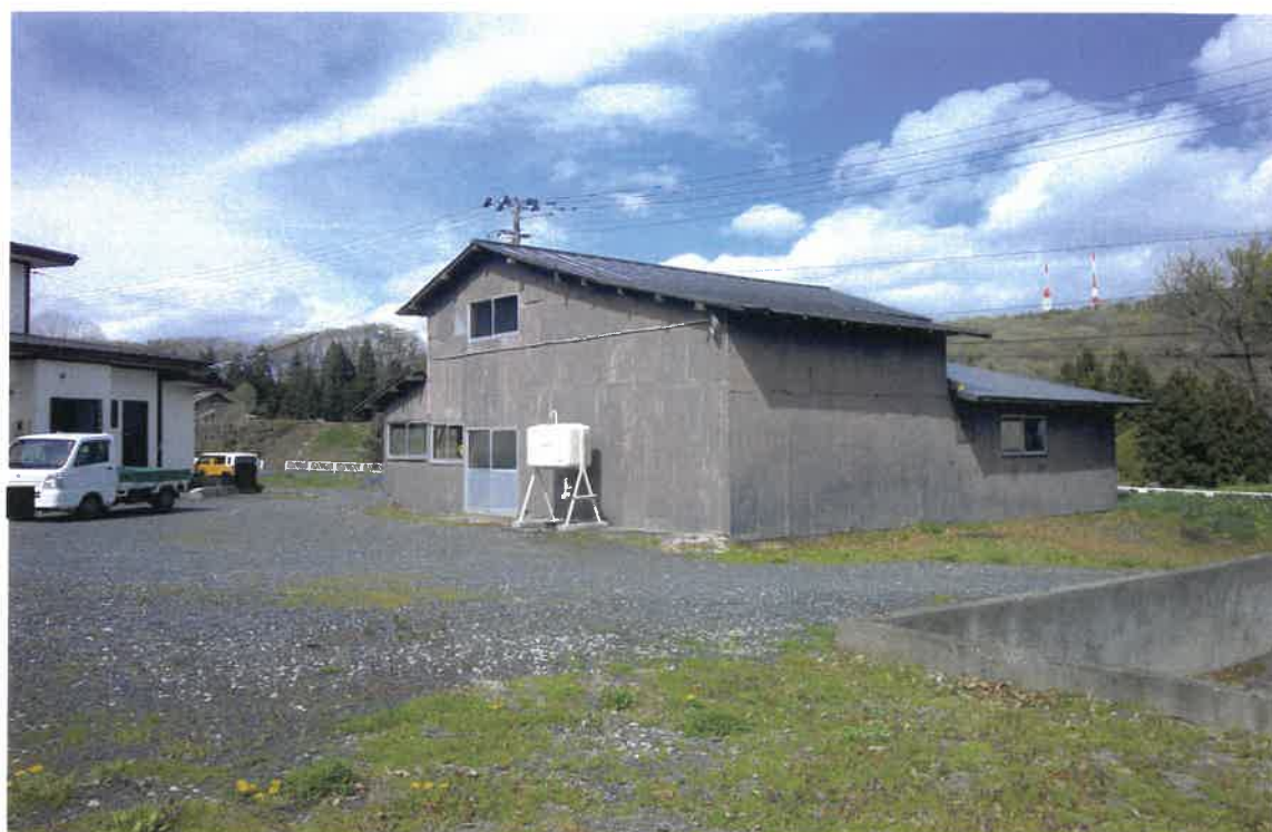
写真⑥ (物件 2 の土地 目的外建物 2 外観)
