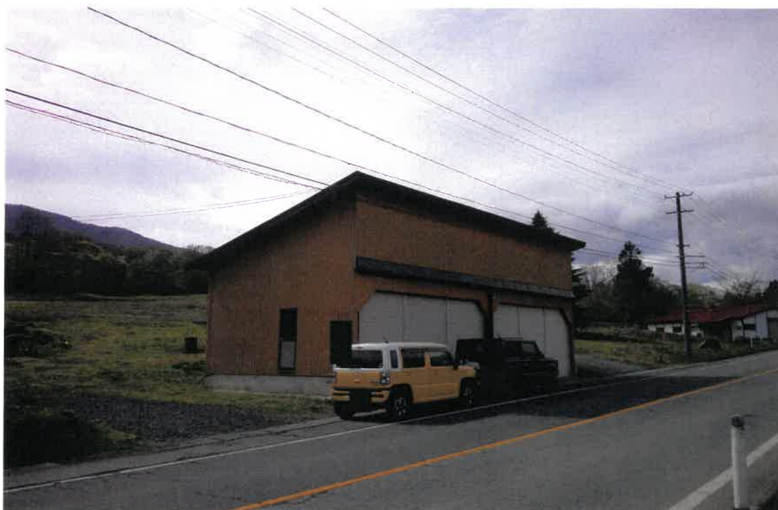
写真②(物件1の土地 目的外附属建物1外観)
