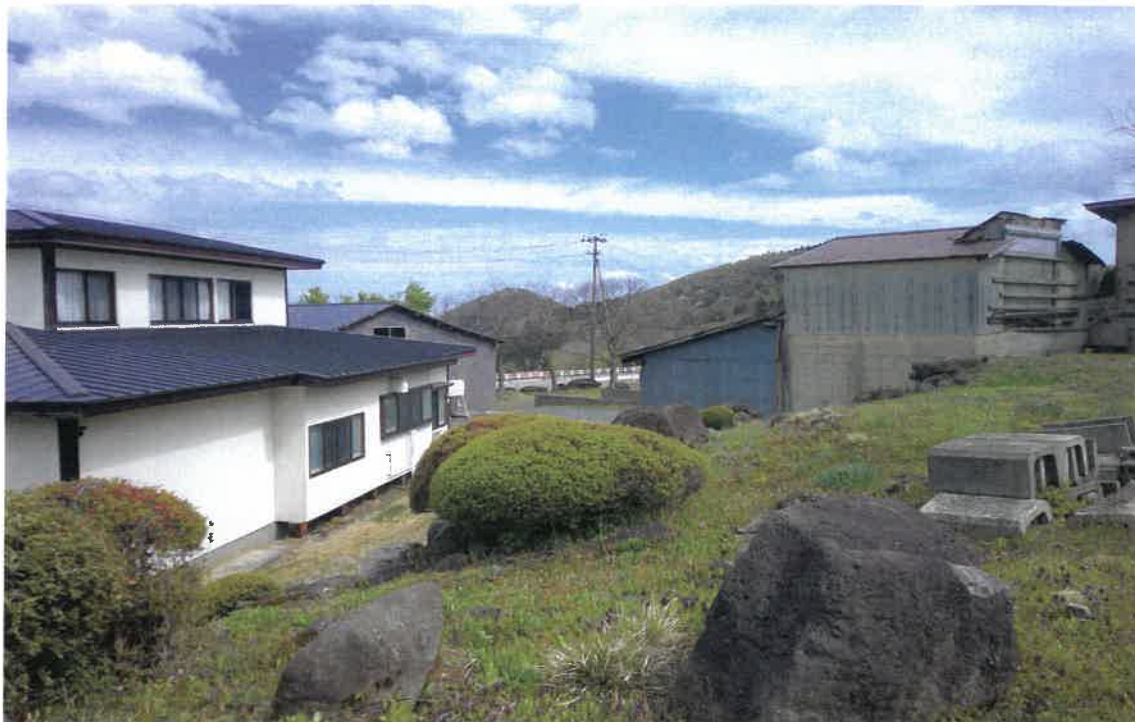
写真③(物件1の土地 南東側境界付近)
