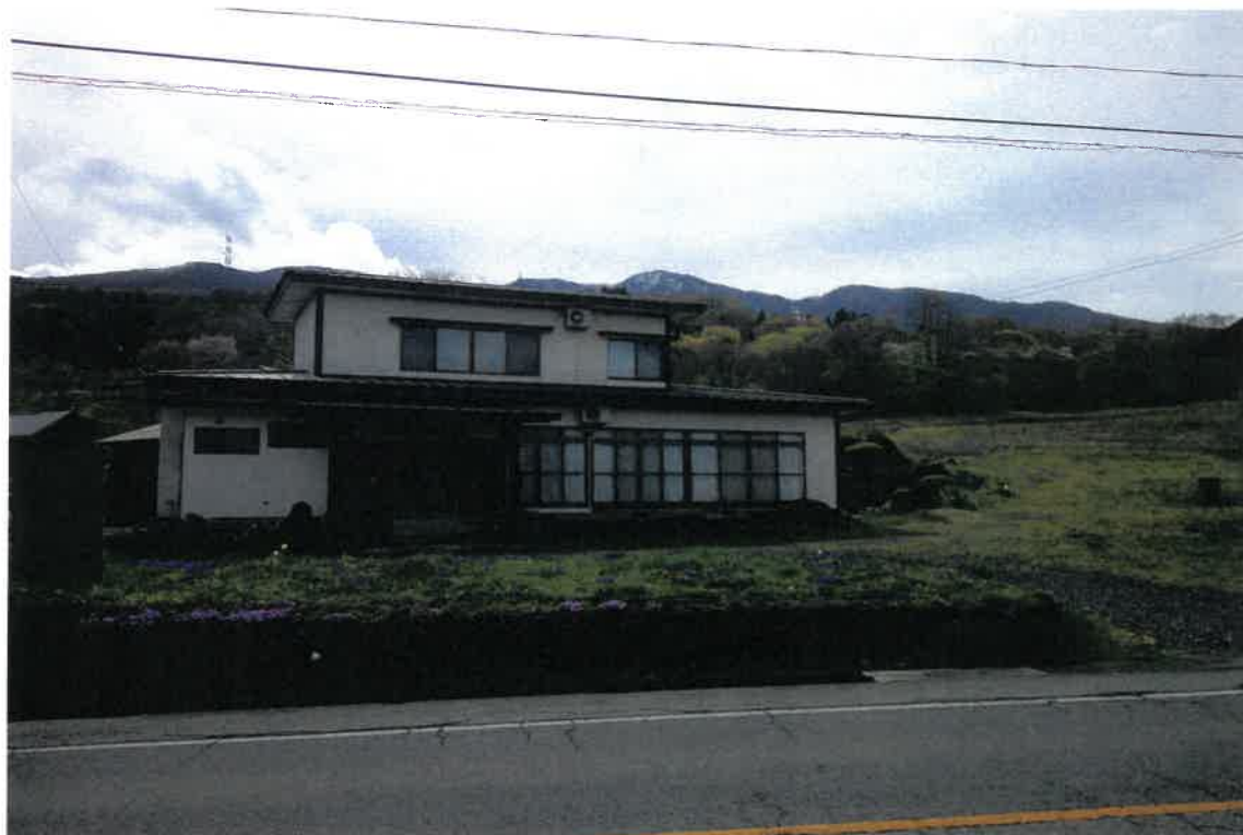
写真①(物件1の土地 北西側舗装市道より 目的外建物1外観)
