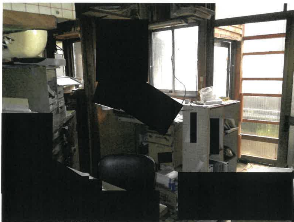
写真⑥(物件4 1階 事務室)
