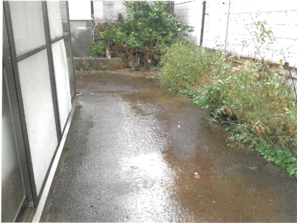
写真③(物件3 南東側端部分境界付近)
