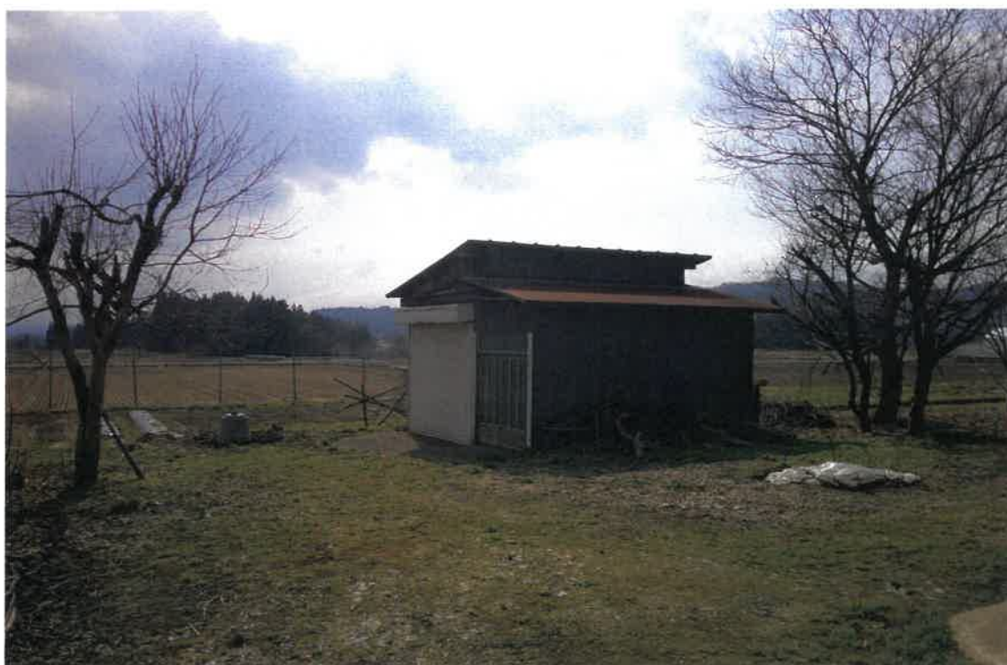
写真⑥ (仮設物置)
