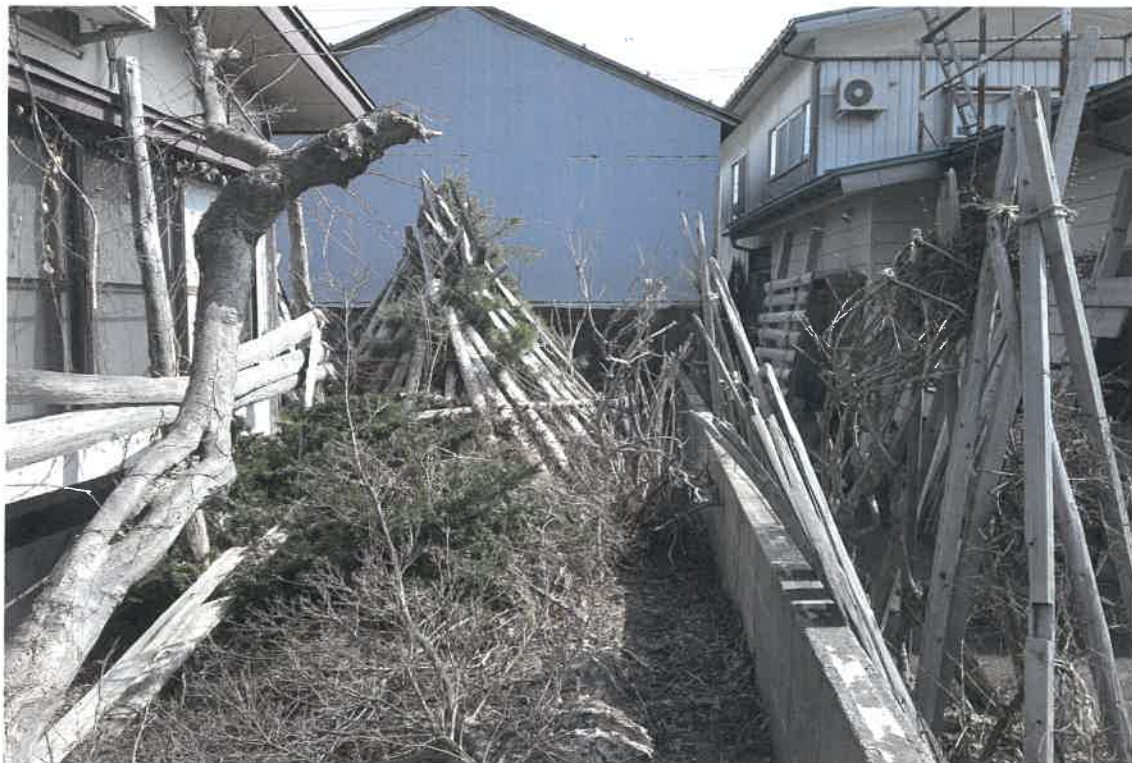
写真⑦(物件1 西側から東側の附属建物(符号1)方向撮影)
