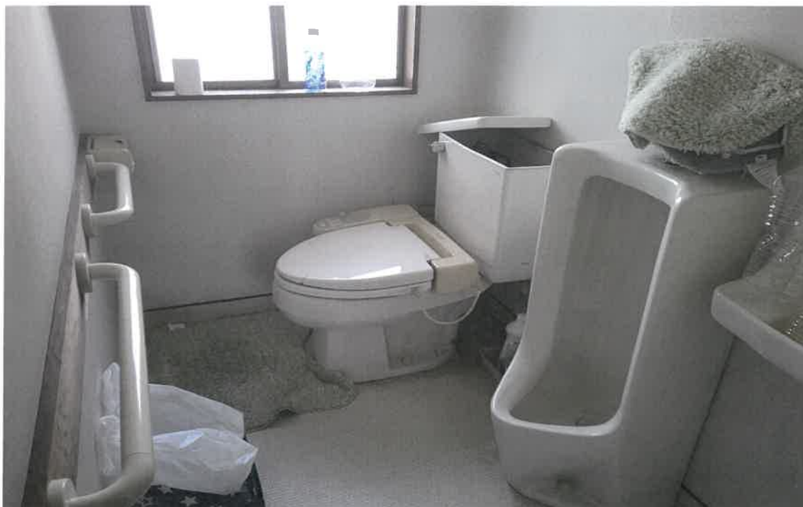
写真⑱(物件4 1階 トイレ)
