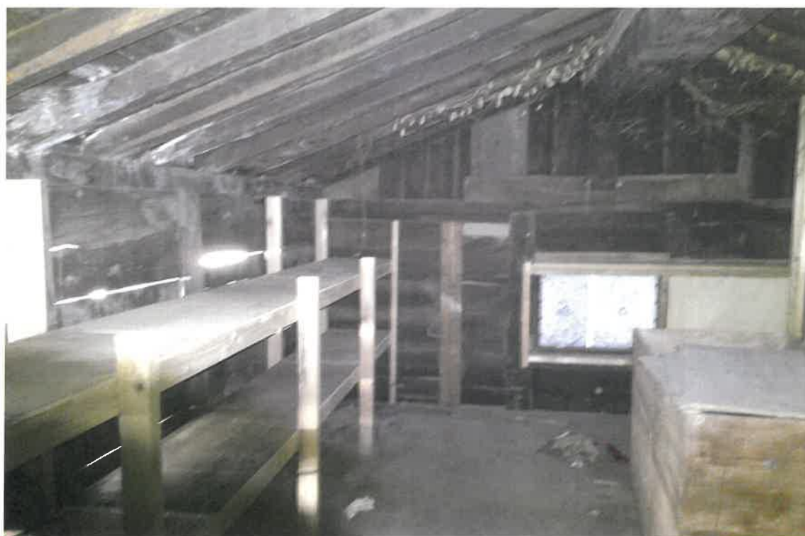
写真⑯(物件3 附属建物(符号2)2階)
