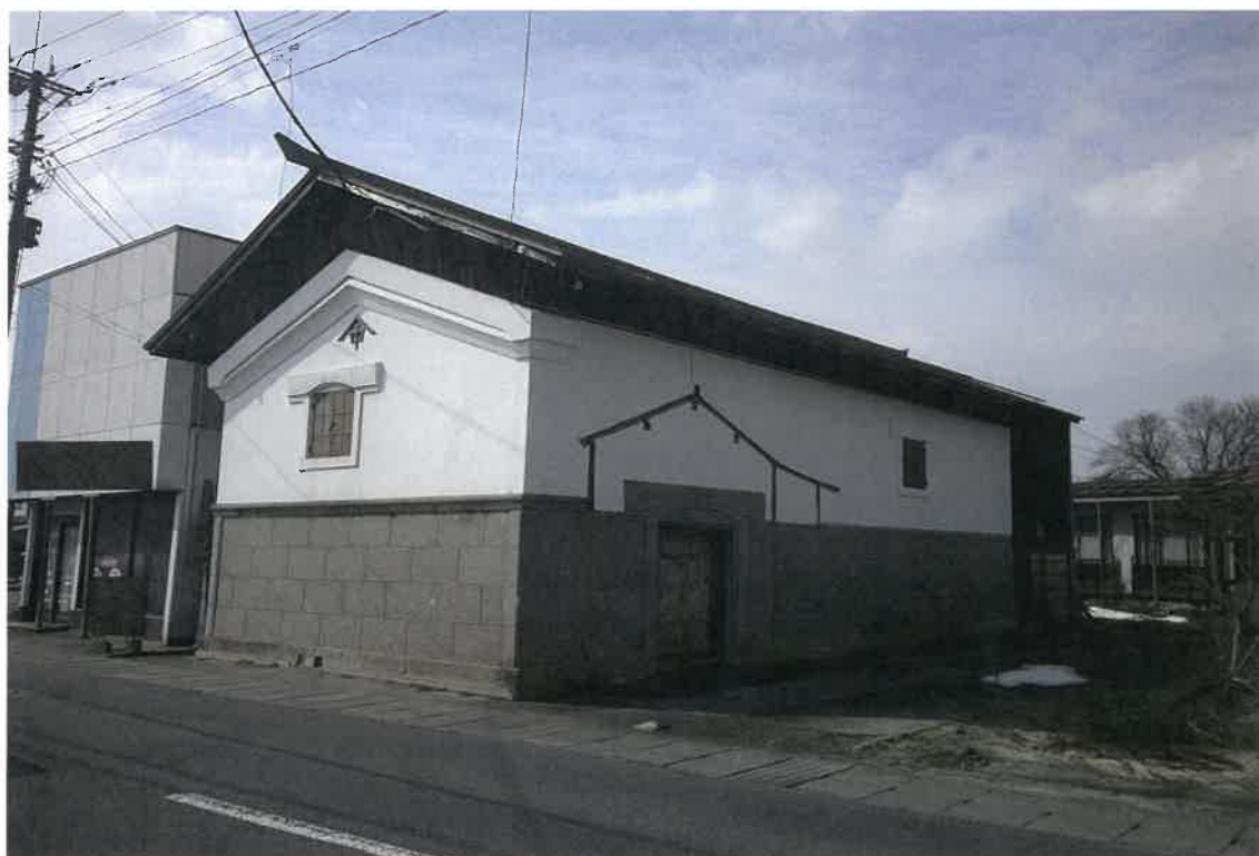
写真②(物件 3 附属建物(符号 1)外観)
