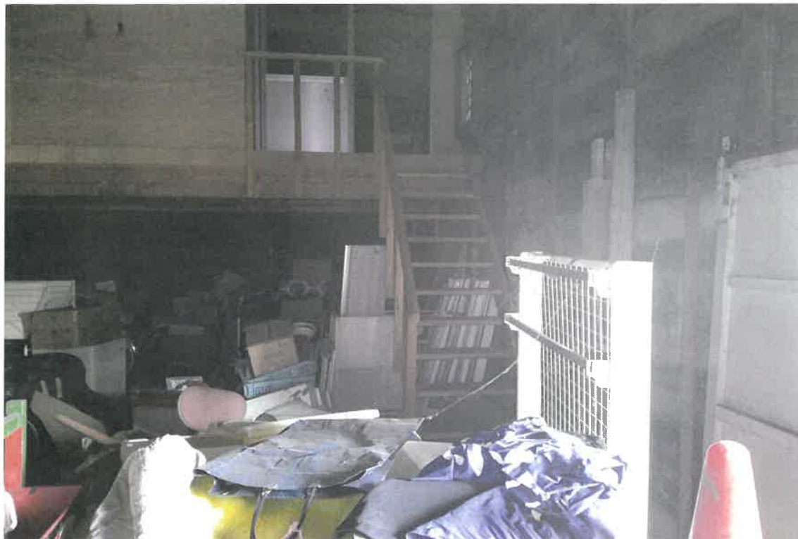
写真⑪(物件3 附属建物(符号1)1階から2階の階段方向撮影)
