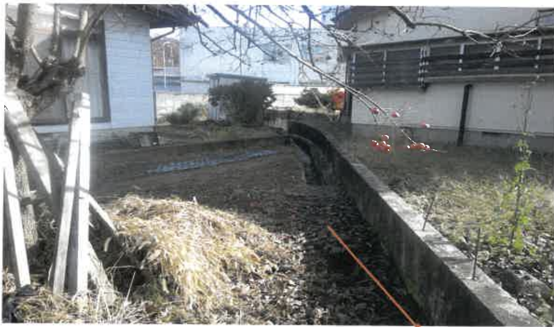
水路の上が蓋で塞がれている部分
