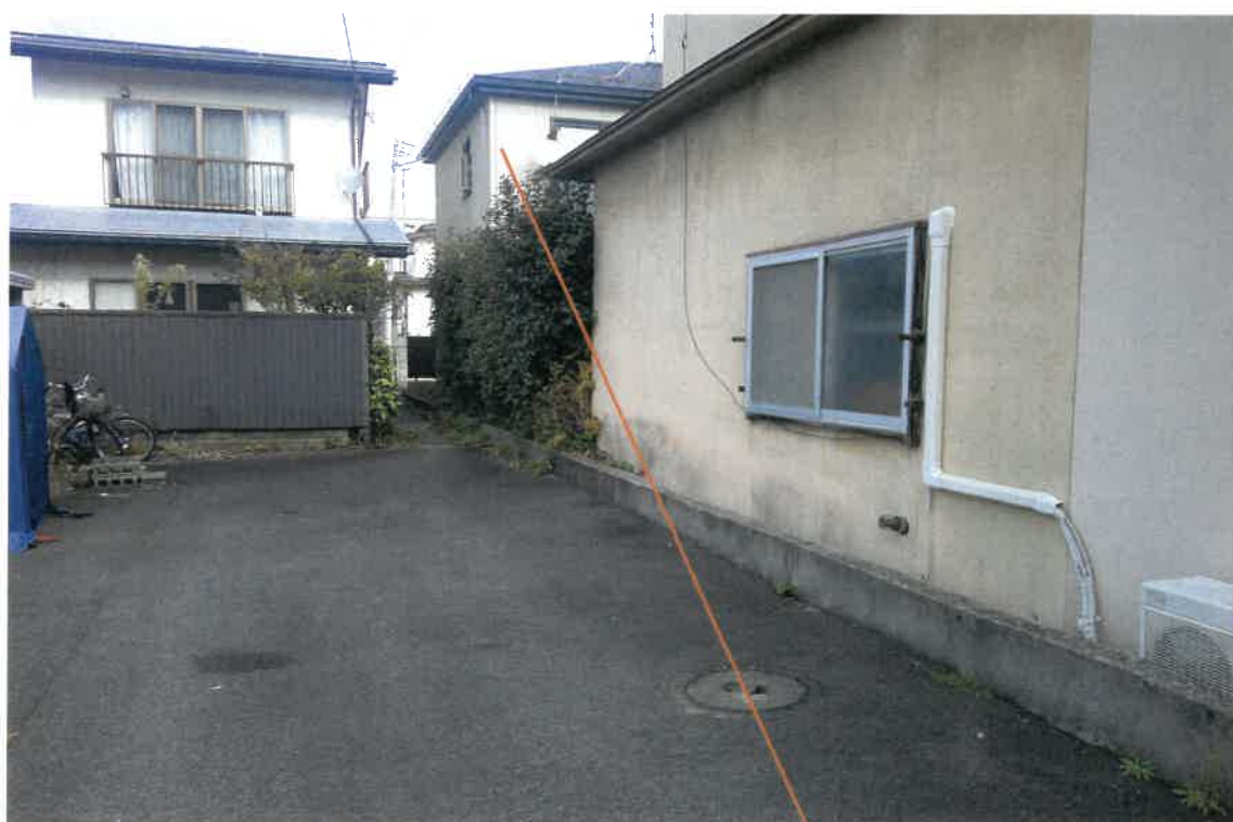
写真②(物件1 北西側境界付近)
