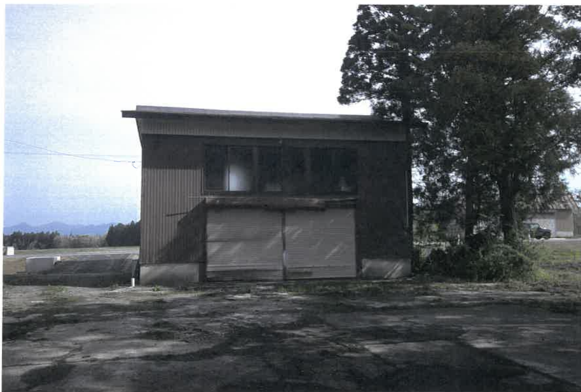
写真②(物件 2 未登記附属建物 1 建物外観)
