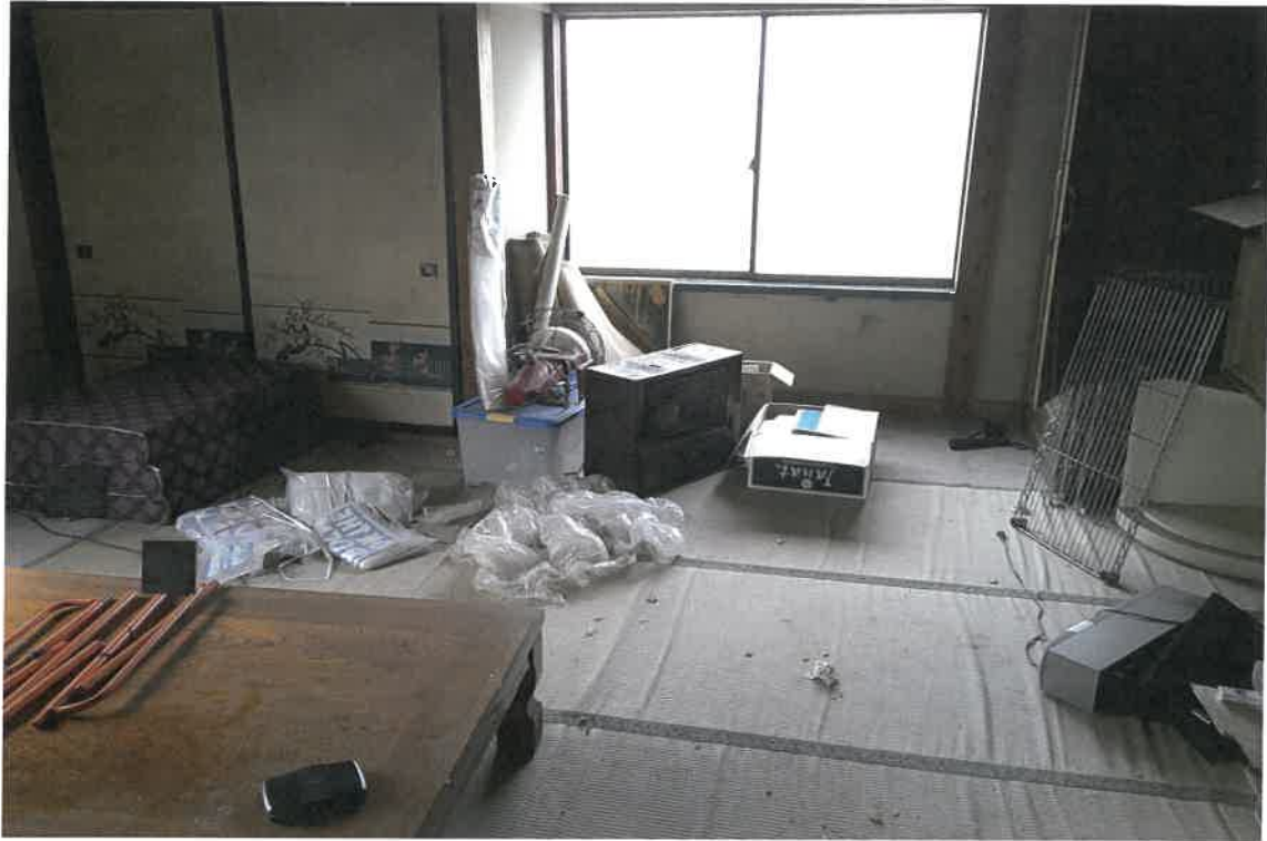
写真⑱(物件 2 未登記附属建物 1 2階 洋室)
