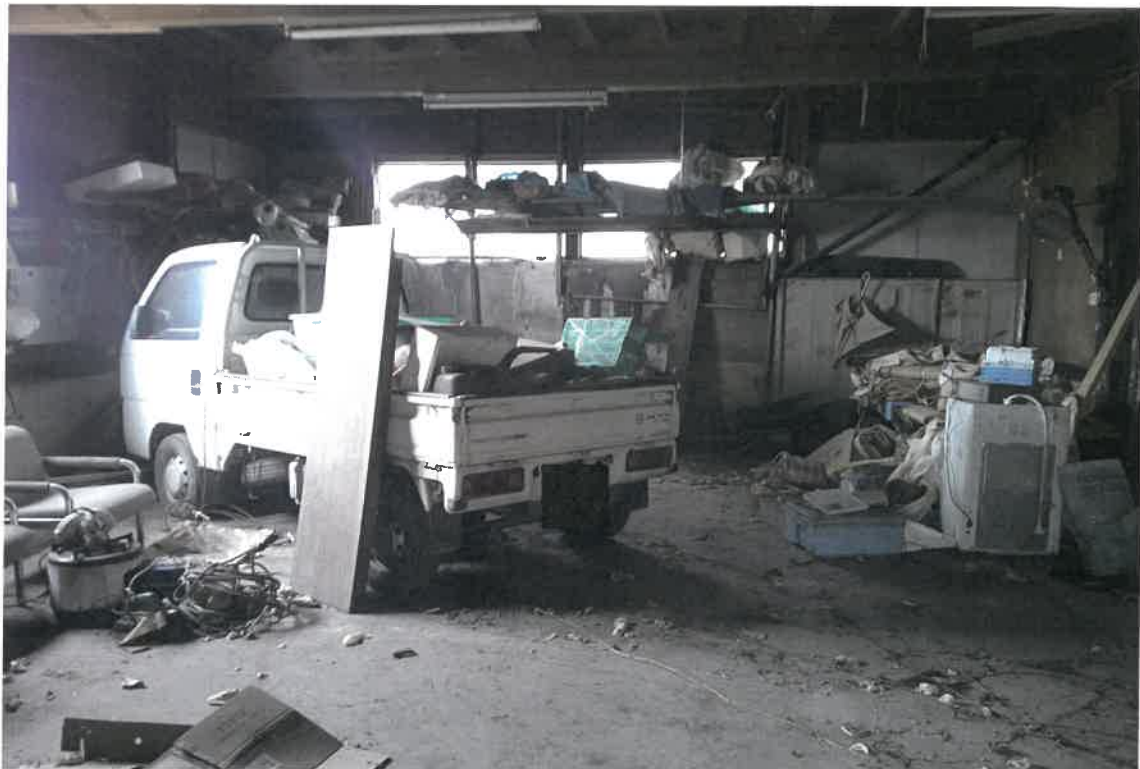
写真⑱(物件 2 未登記附属建物 1 1階車庫)
