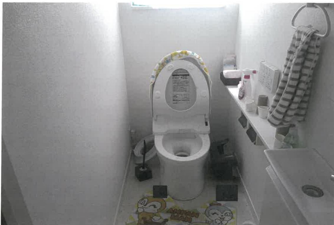
写真⑨(物件2 1階 トイレ)
