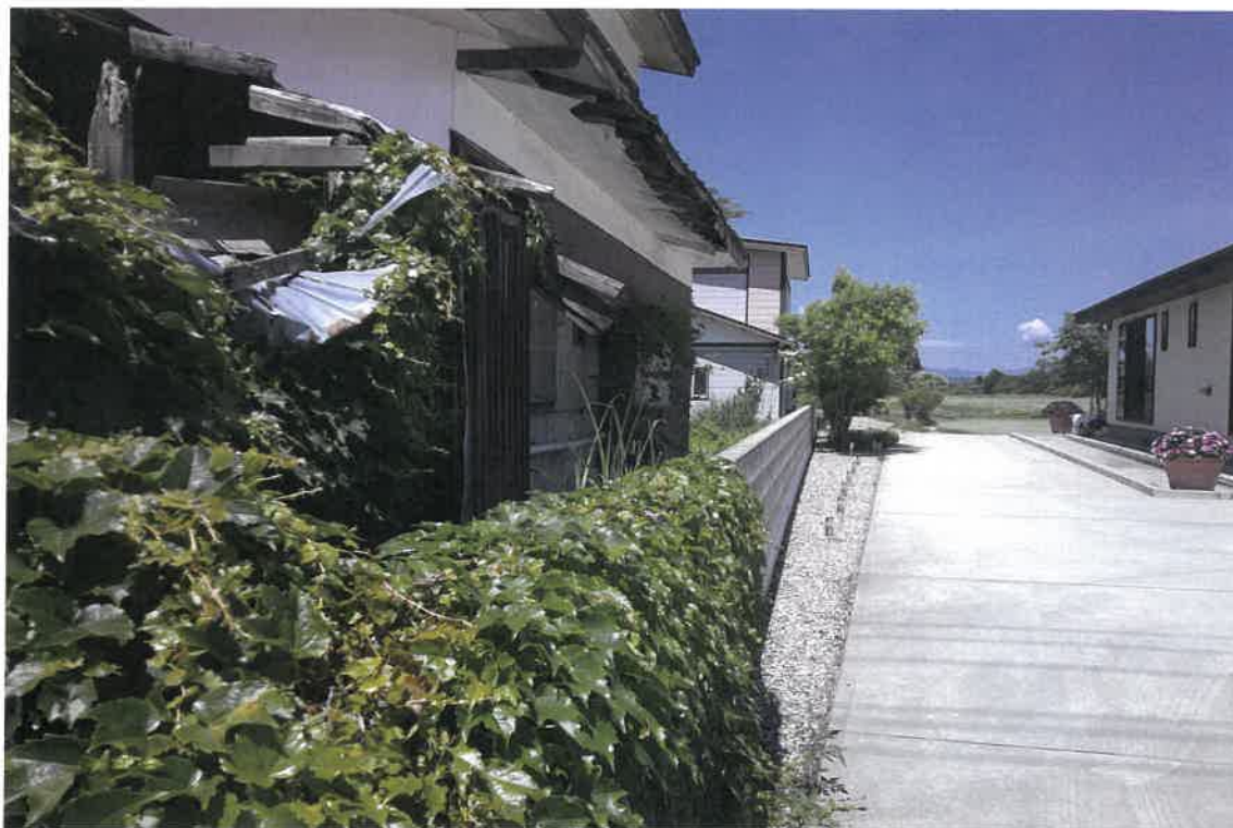
写真②(物件 1 北東側境界付近)
