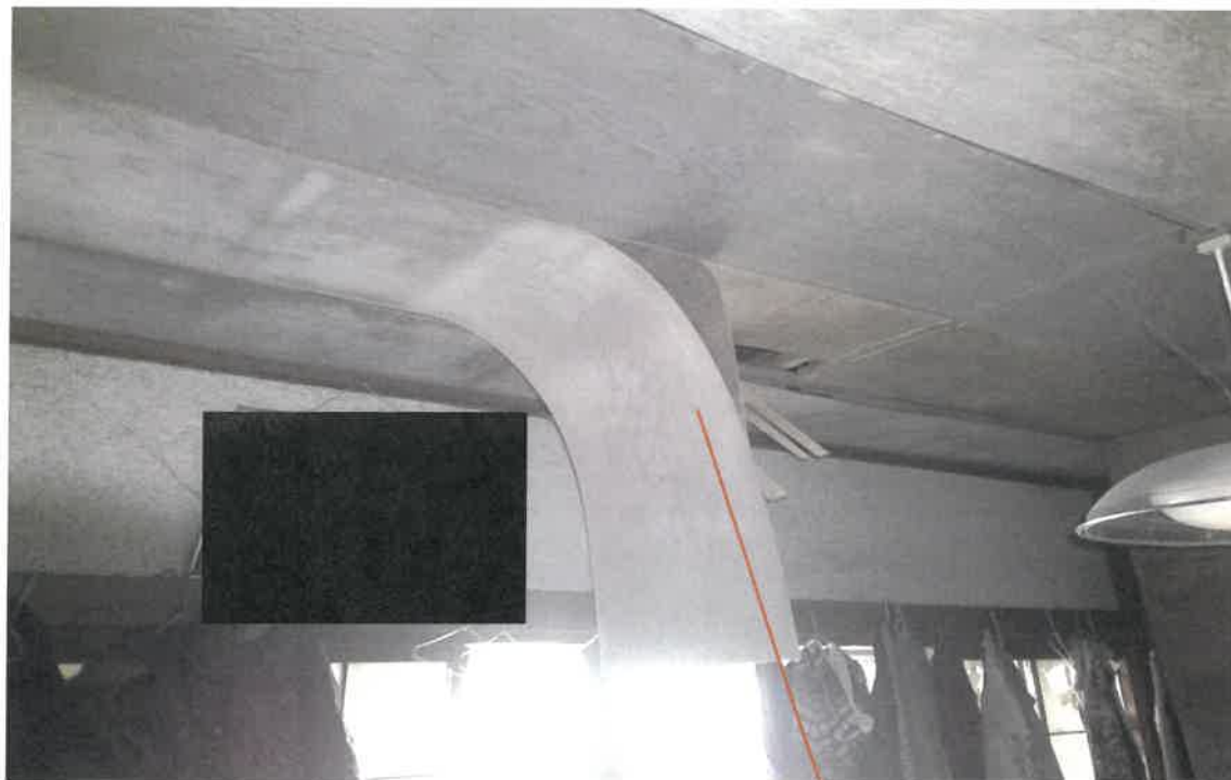
写真⑩(物件2 1階 和室)
