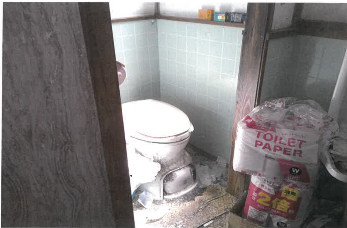
写真⑦(物件2 1階 トイレ)
