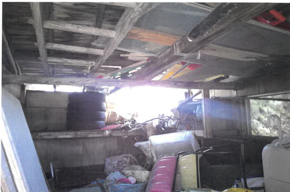
写真⑭(物件 2 東側物置内部)
