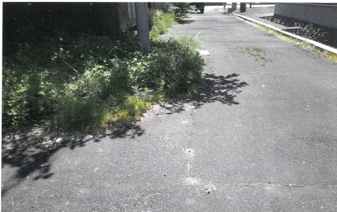
写真④(物件1 南西側境界付近)
