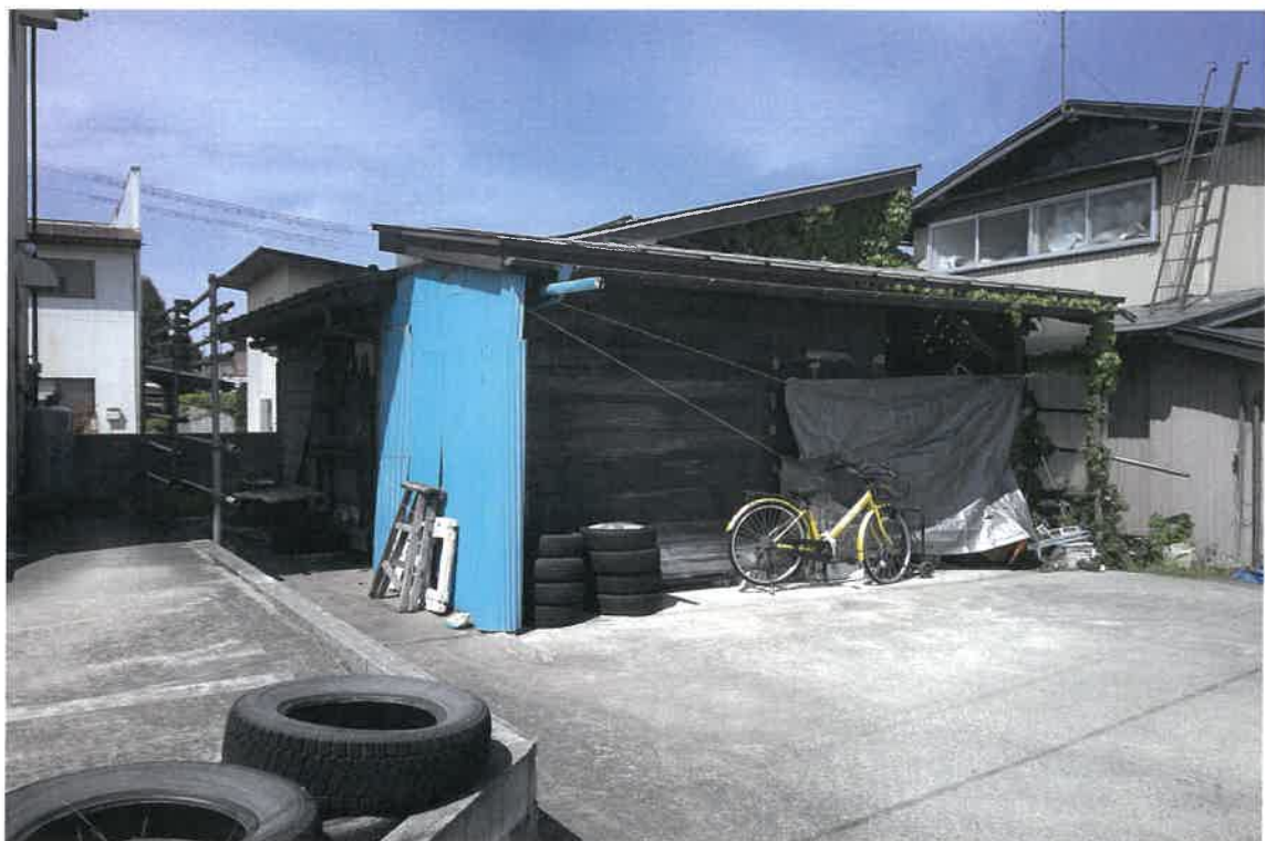
写真②(物件 2～4 目的外建物①付近)
