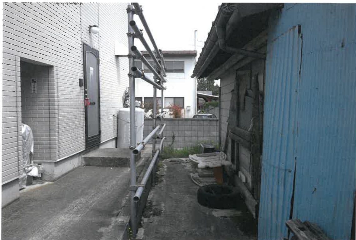
写真④(物件4 西側境界付近)
