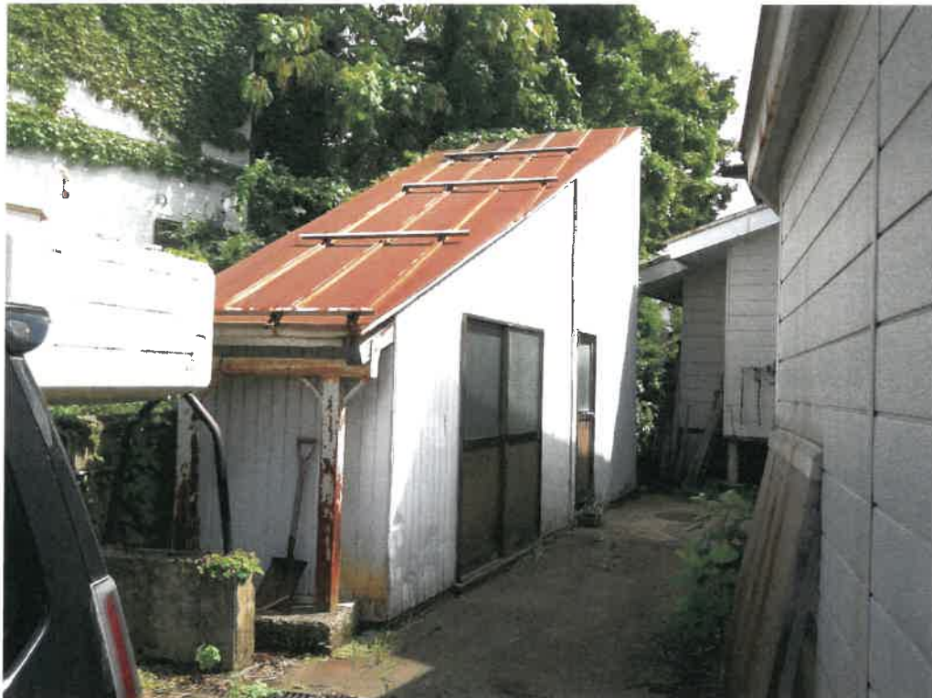
写真③(物件4 未登記附属建物)
