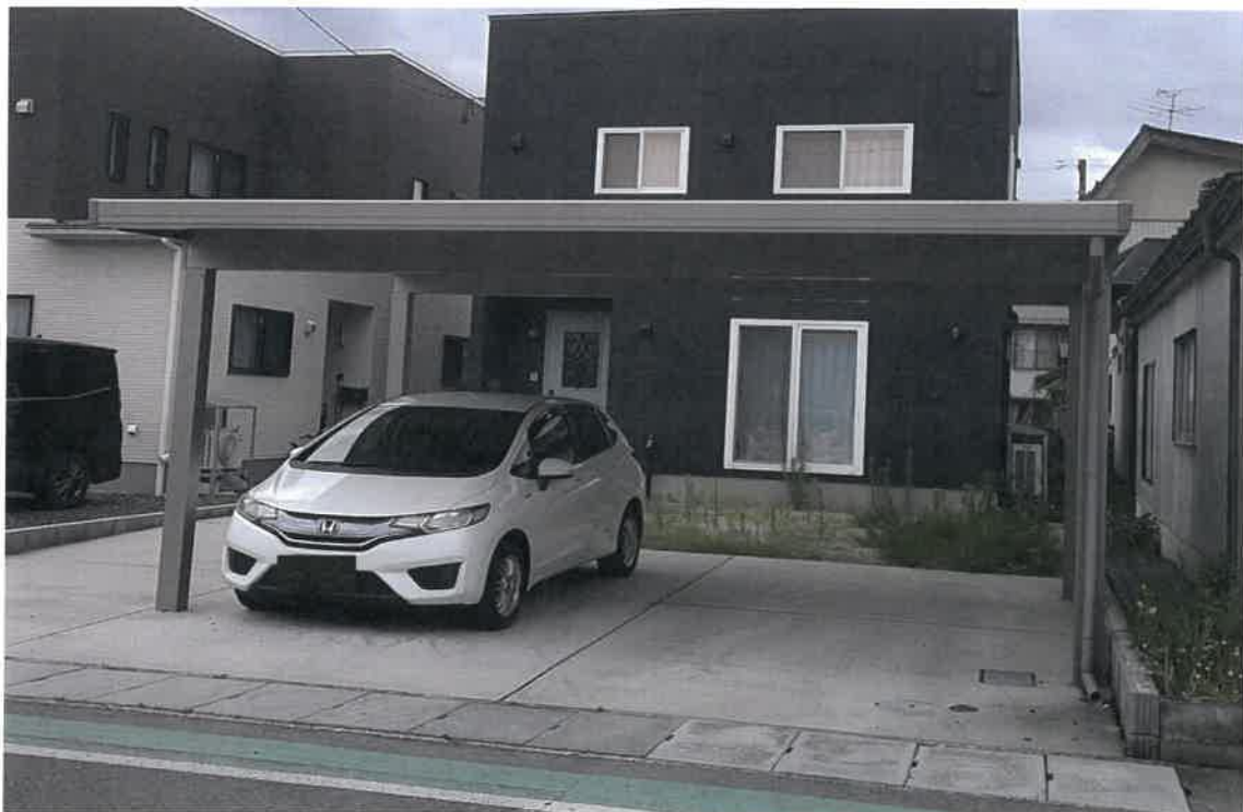
写真⑥(物件1 カーポート)
