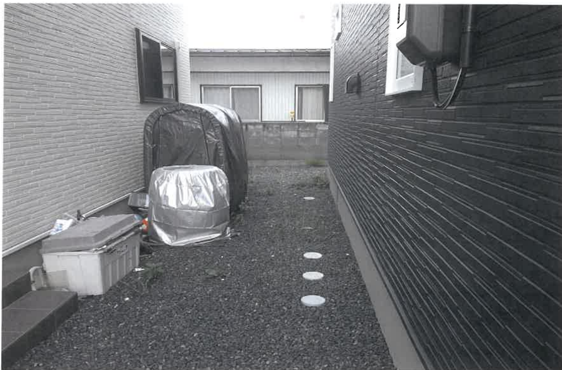
写真③(物件1 北西側境界の北側部分)
