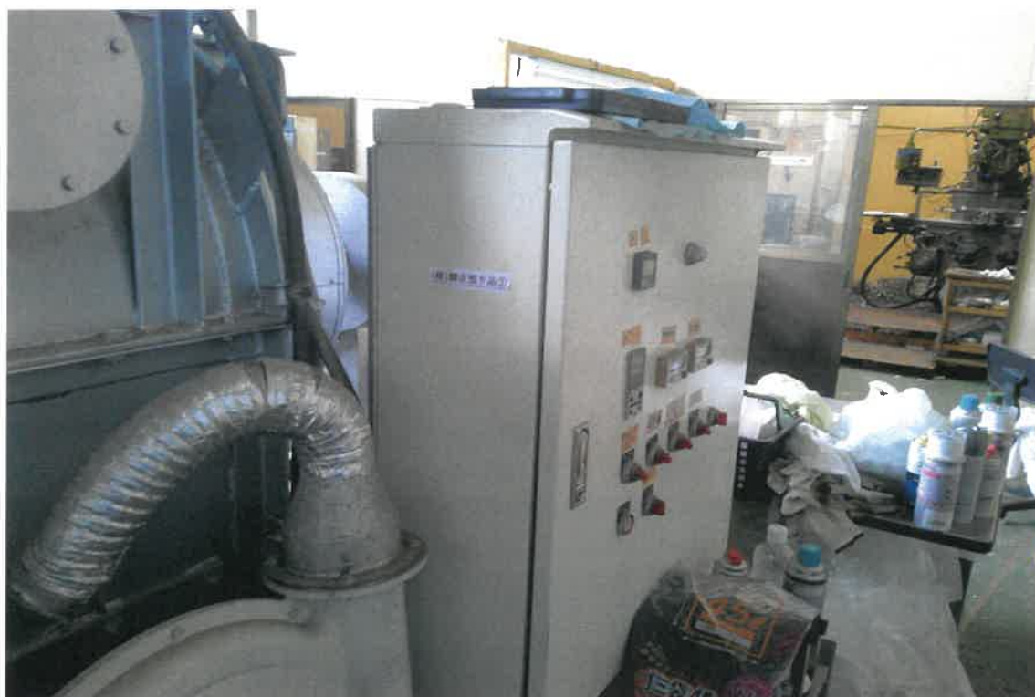
写真⑩ (物件 3 1階 作業場)
