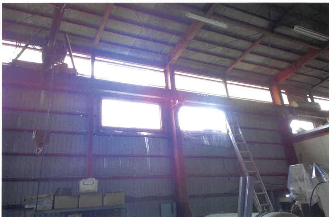
写真⑧(物件3 1階 作業場壁)
