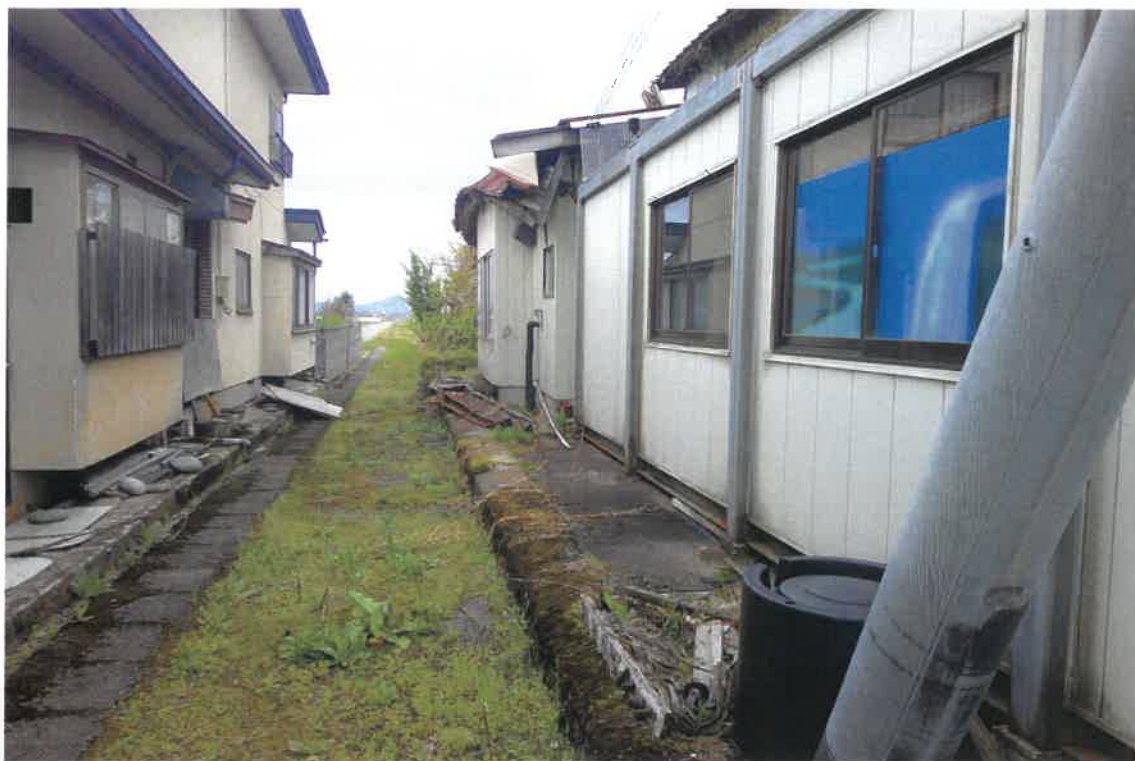
写真③ (物件 1 北西側境界付近)
