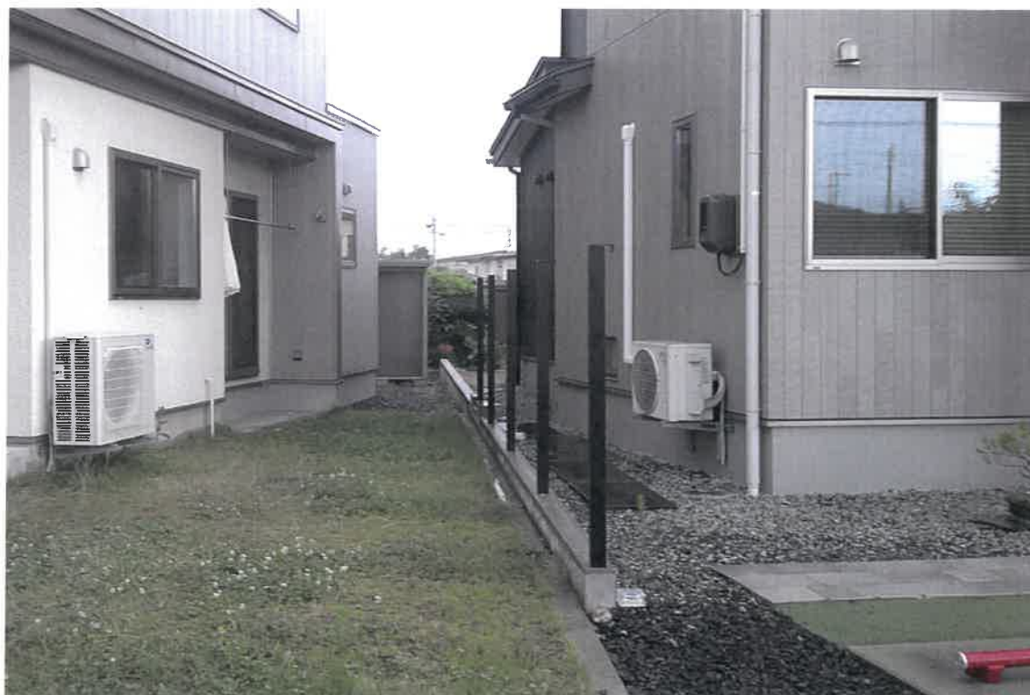
写真②(物件 1 東側境界付近)
