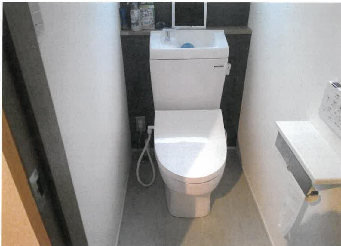
写真⑫(物件2 2階 トイレ)
