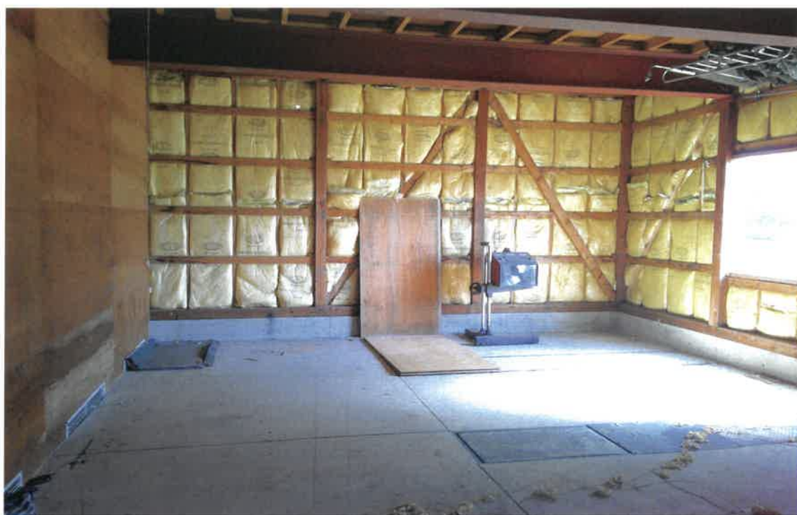
写真②(物件 8 1階 倉庫)
