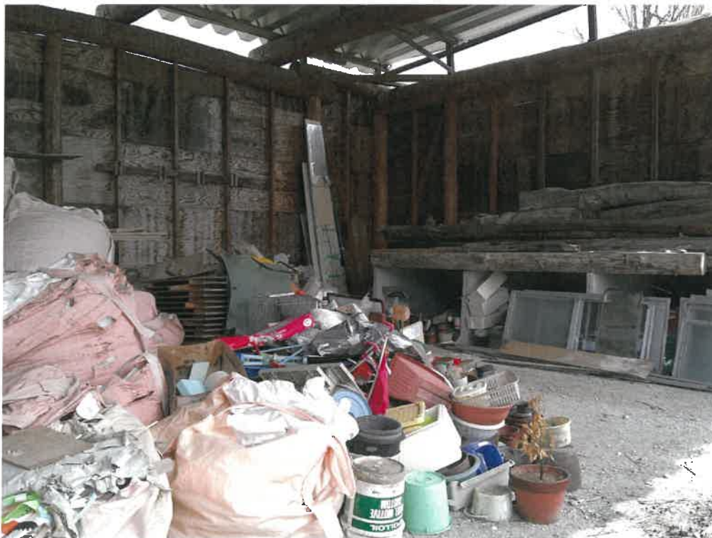
写真② (物件 4 建物内部)
