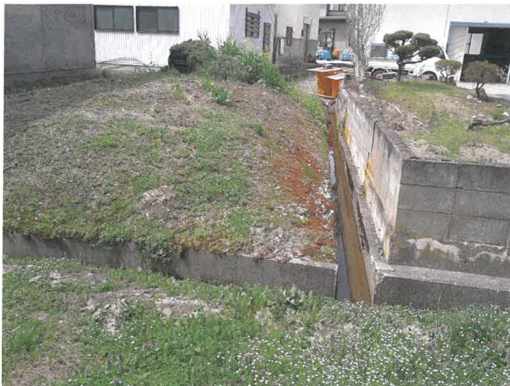
写真⑦ (物件2 北側 境界付近)
