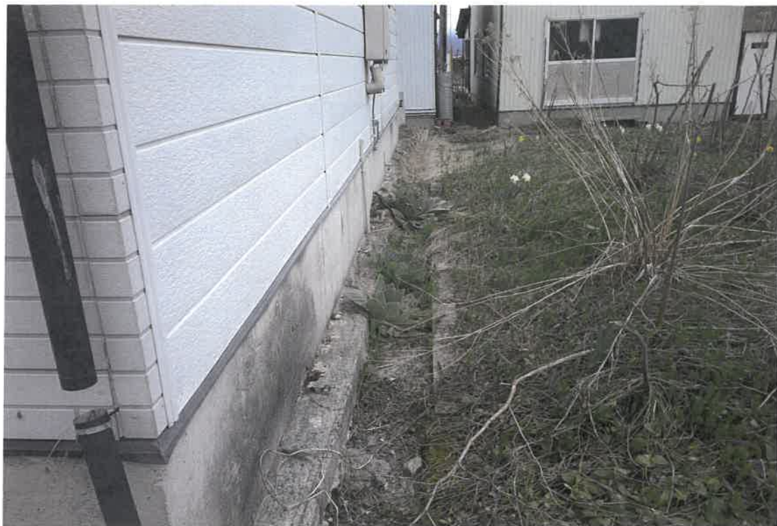
写真⑤(物件1 北東側境界付近)
