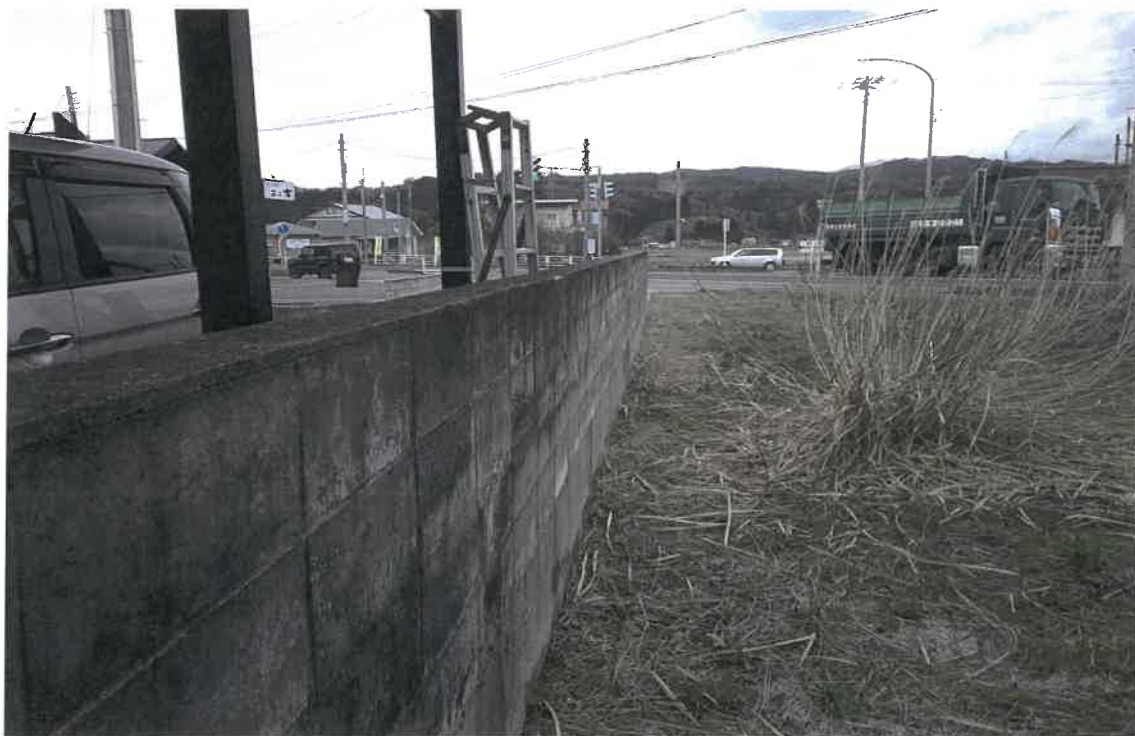
写真③(物件1 南西側境界付近)
