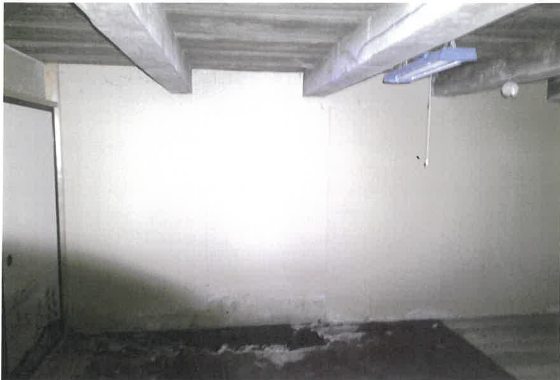
写真⑮(物件3 附属建物(符号2)1階)
