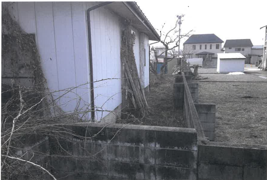
写真④(物件 1、2 西側境界付近)
