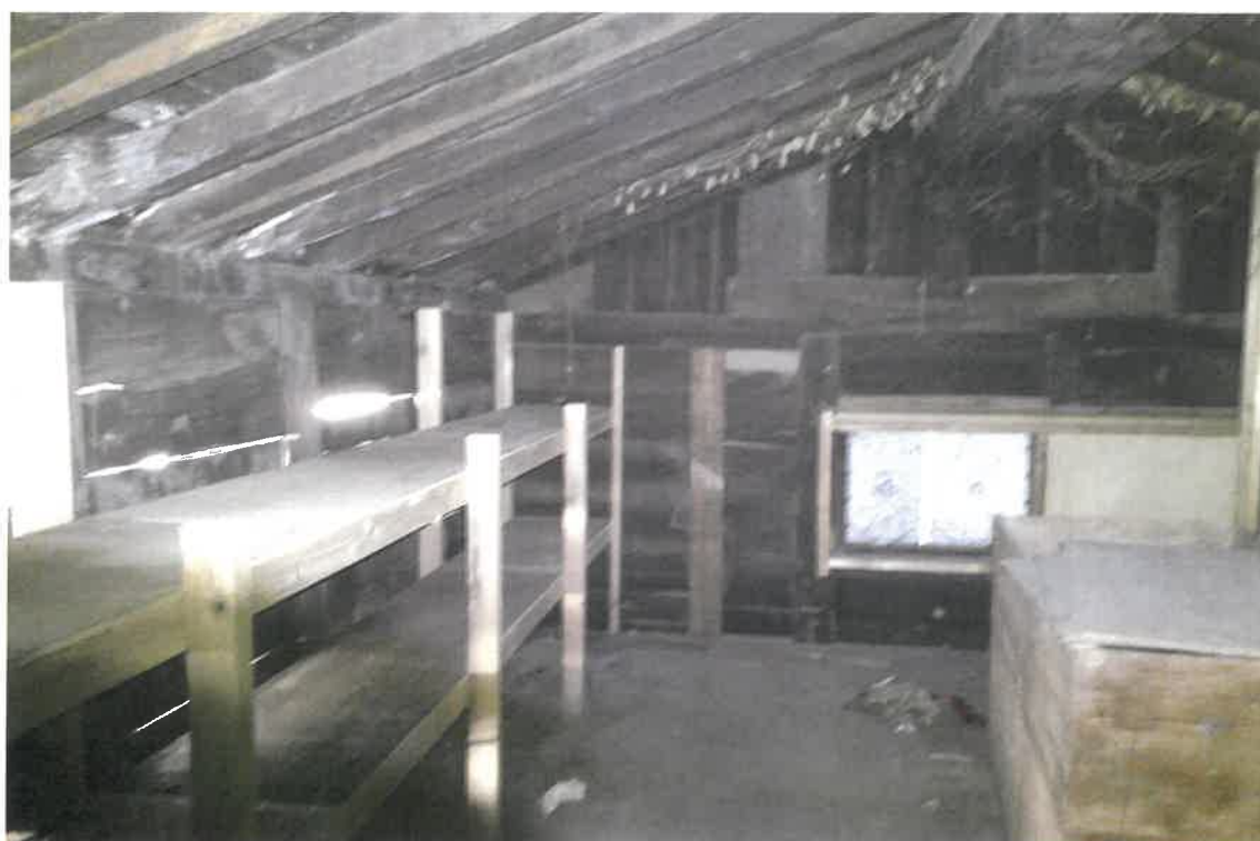
写真⑯(物件3 附属建物(符号2)2階)
