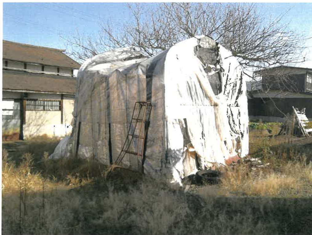
写真⑥ (物件2 北東側 仮設テント)
