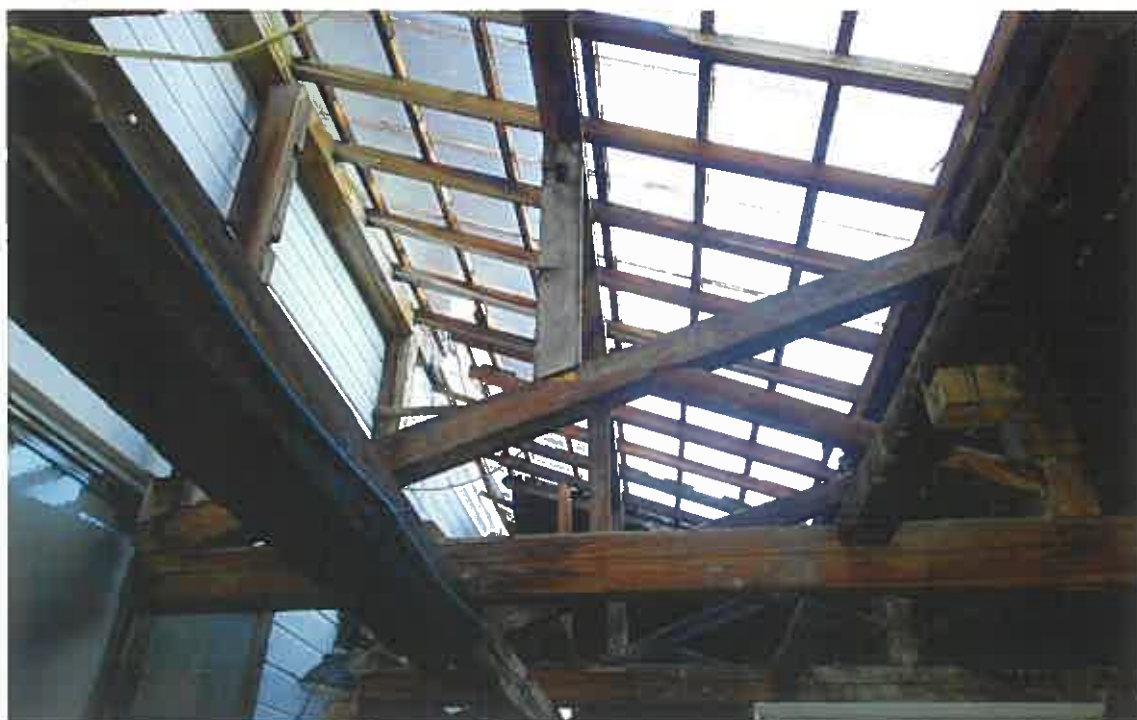
写真⑩(目的外建物天井部分)
