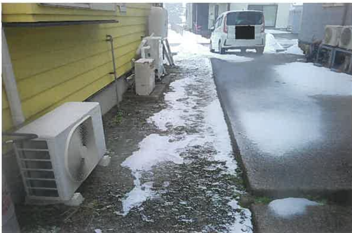
写真②(物件1 北東側境界付近)
