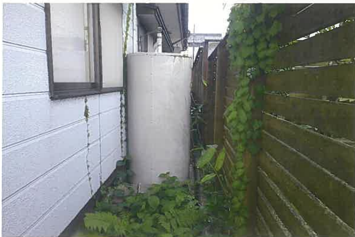
写真⑤(物件1 北西側境界付近 ボイラーあり)
