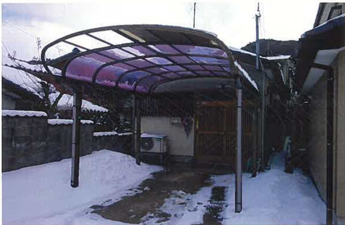
写真①(物件3 建物外観 西側玄関側)
