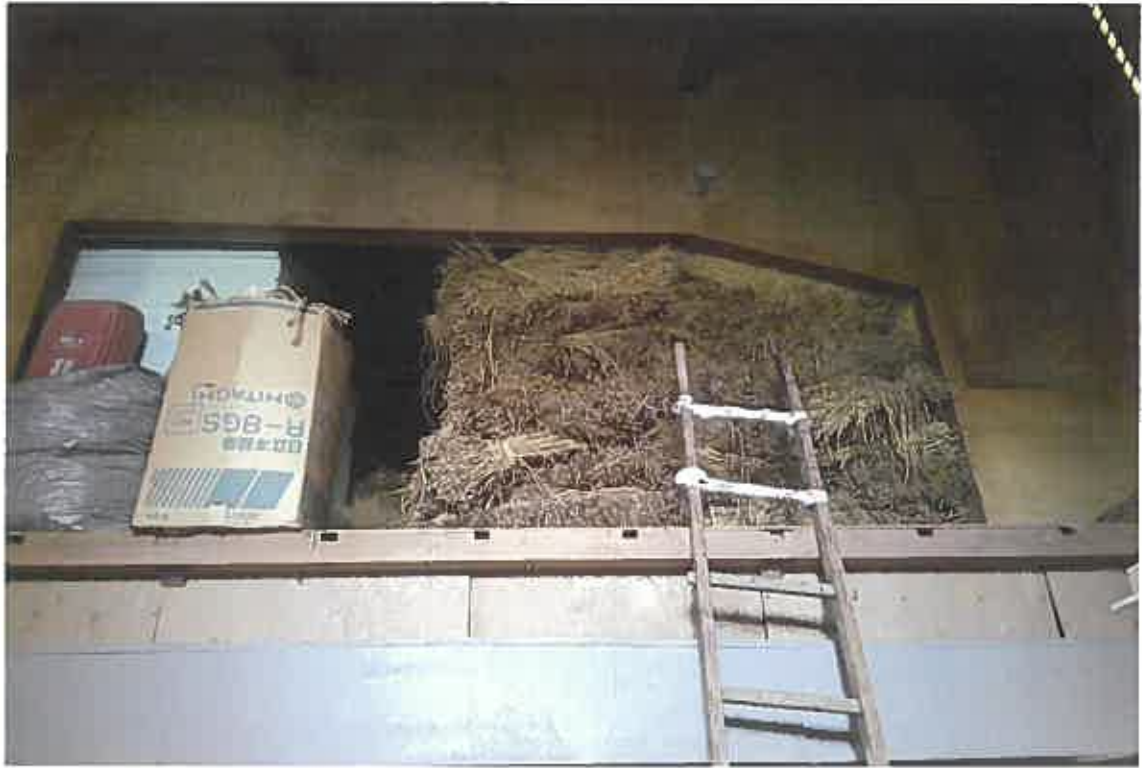
写真㊸(物件3 2階倉庫入り口付近)
