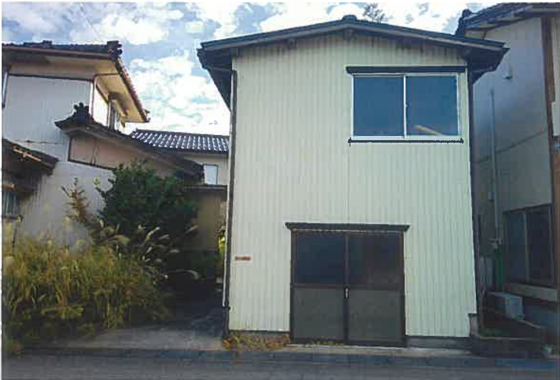
写真②(物件2 附属建物外観)
