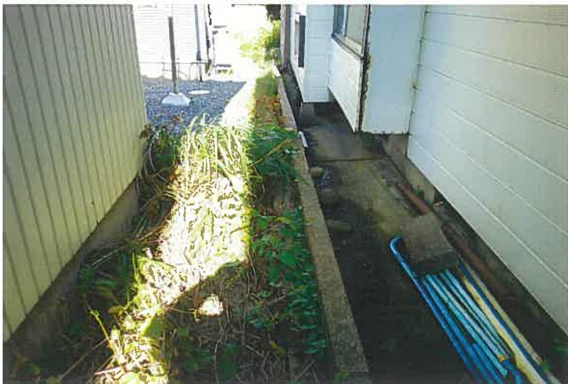
写真④(物件1 東側境界付近)
