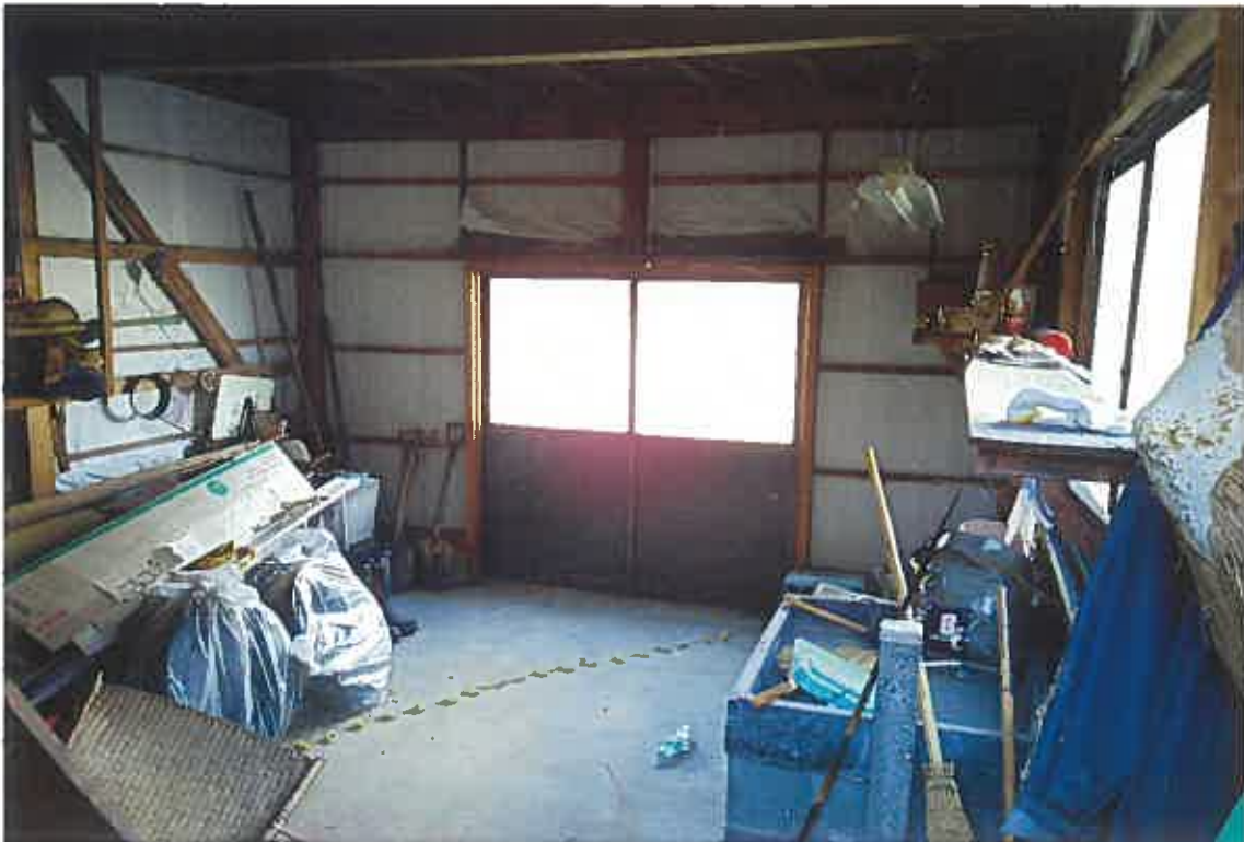
写真⑩(物件2 附属建物(符号1) 1階内部)
