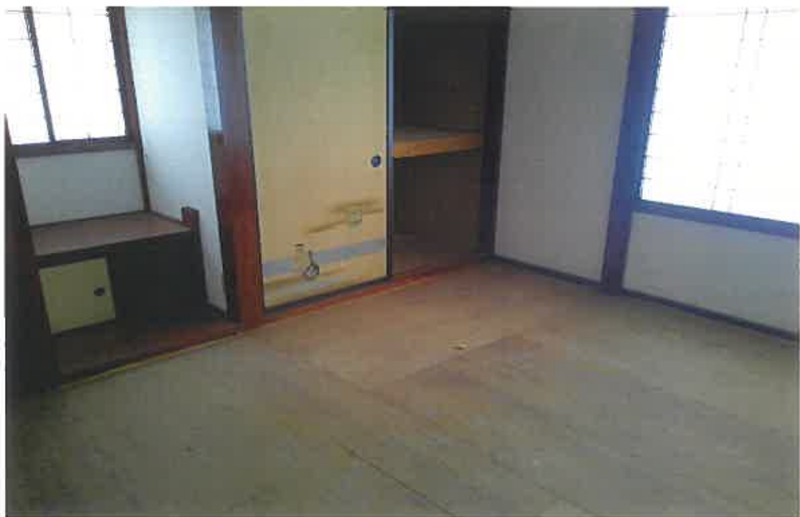
写真⑧(物件3 2階 和室)
