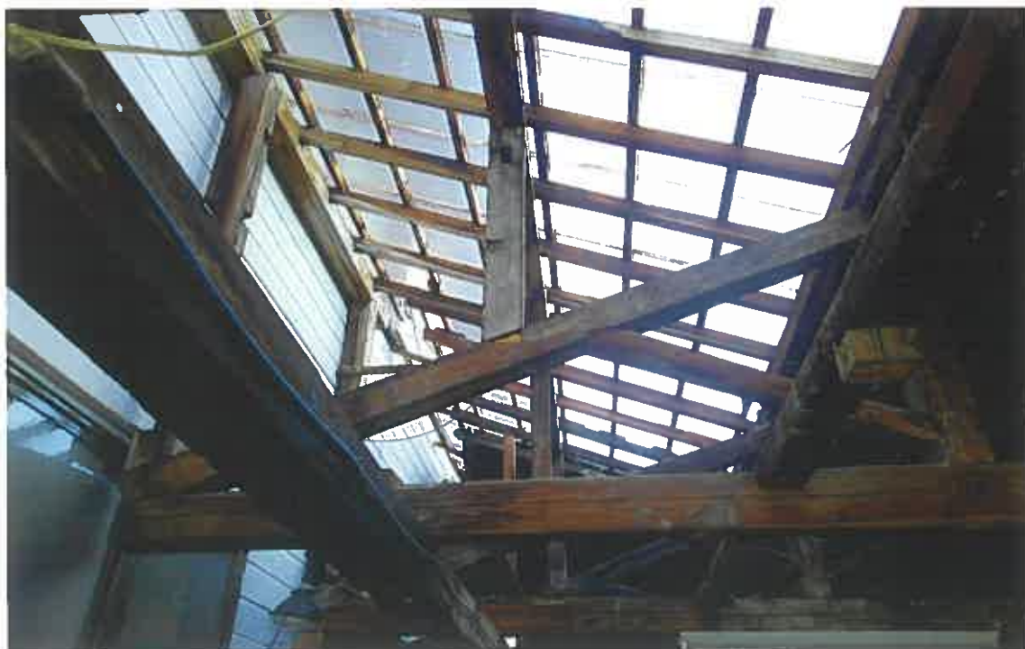
写真⑩(目的外建物天井部分)
