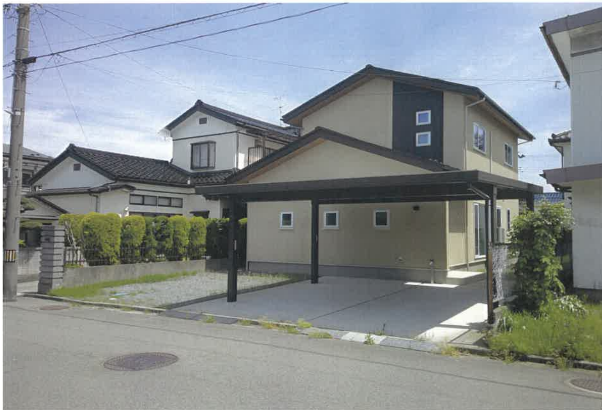
写真①(建物外観)
