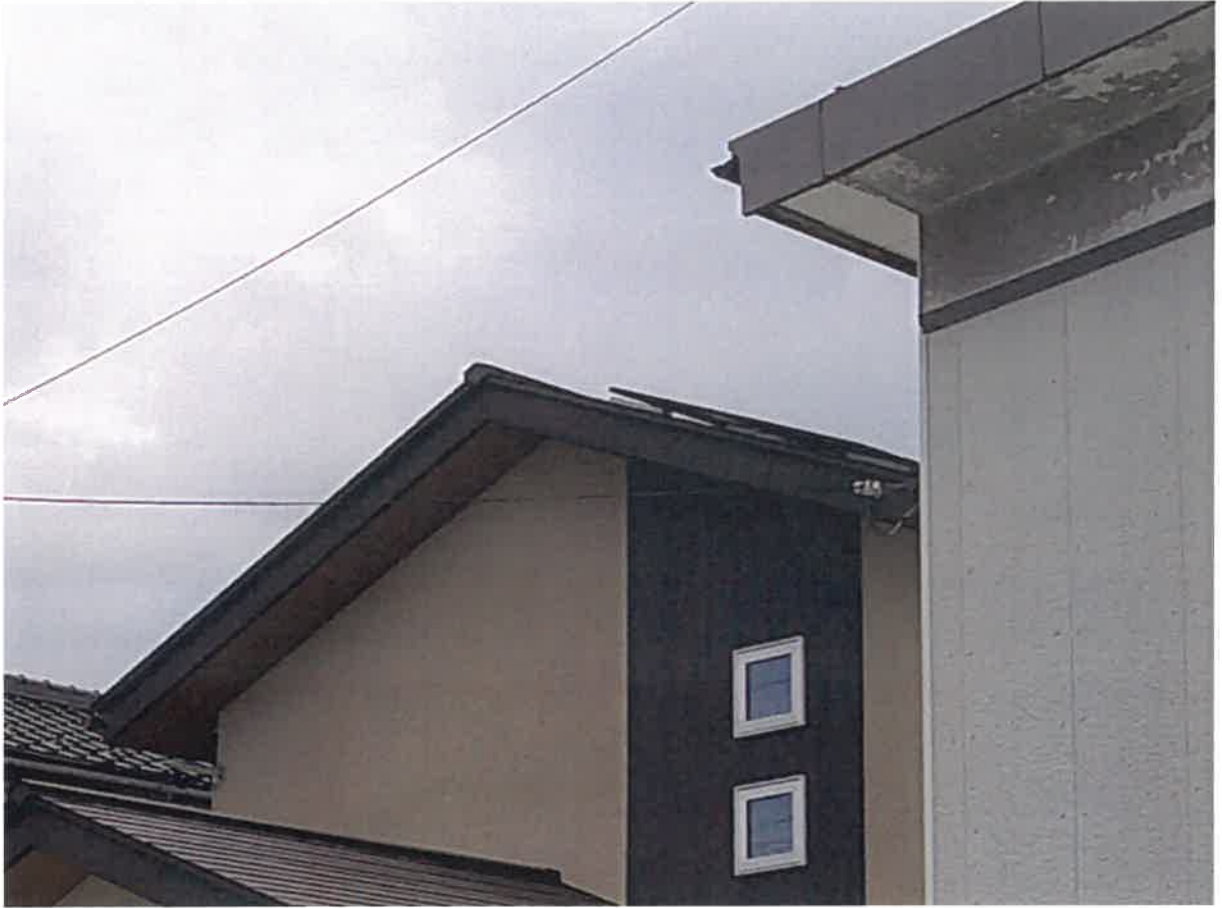
写真⑦(物件2 2階屋根)
