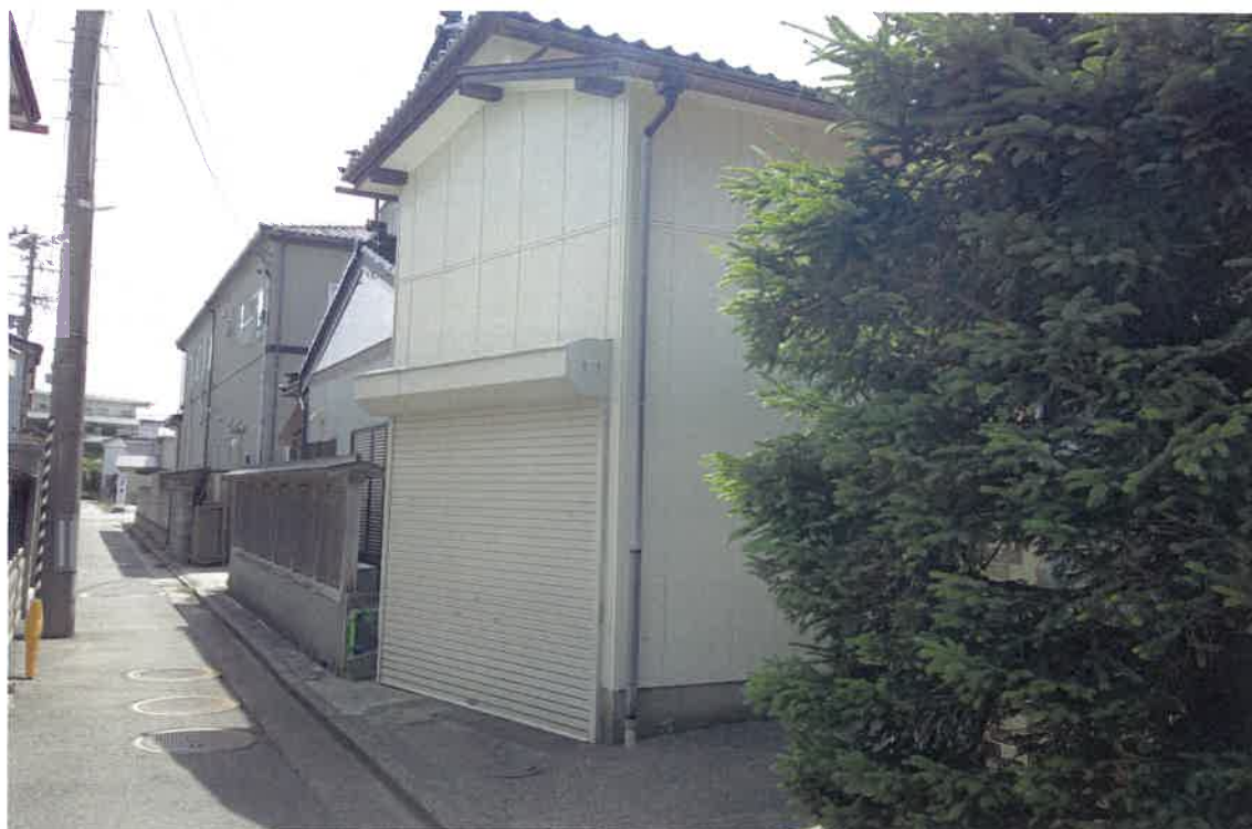
写真②(物件2の建物 未登記附属建物)
