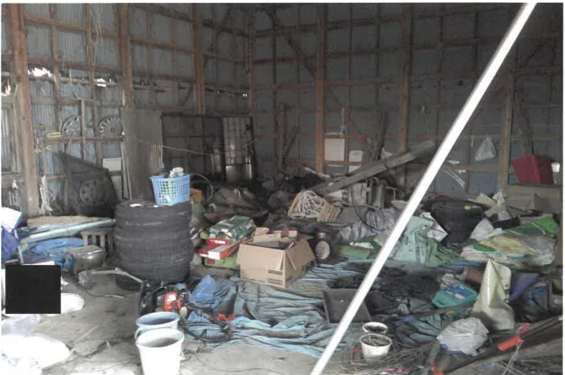
写真⑩(物件3 建物内部)
