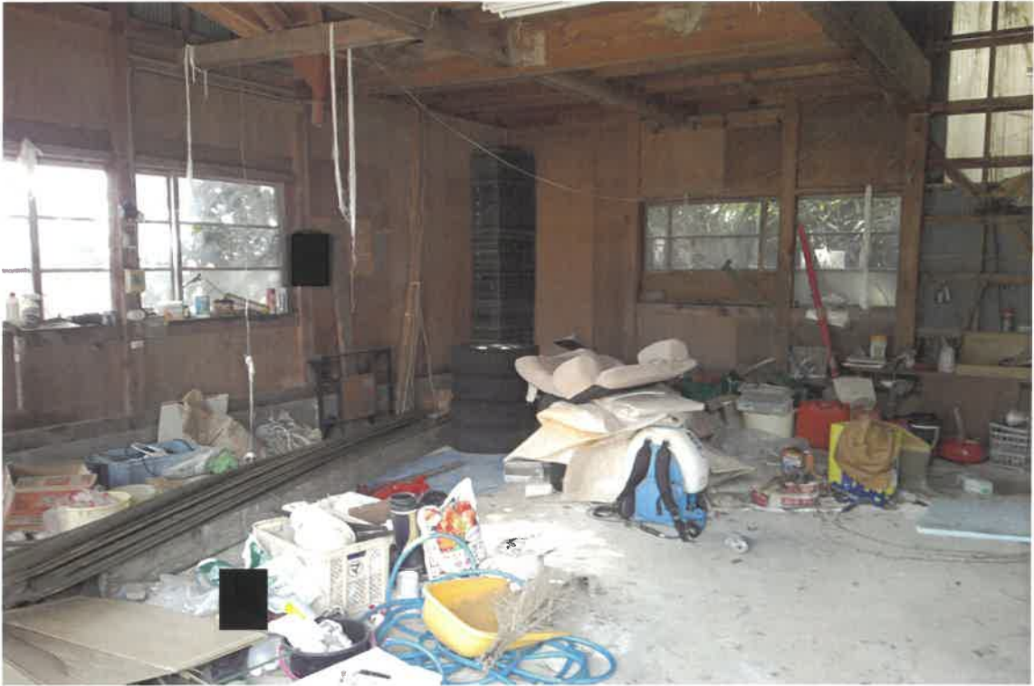
写真⑨(物件3 建物内部)
