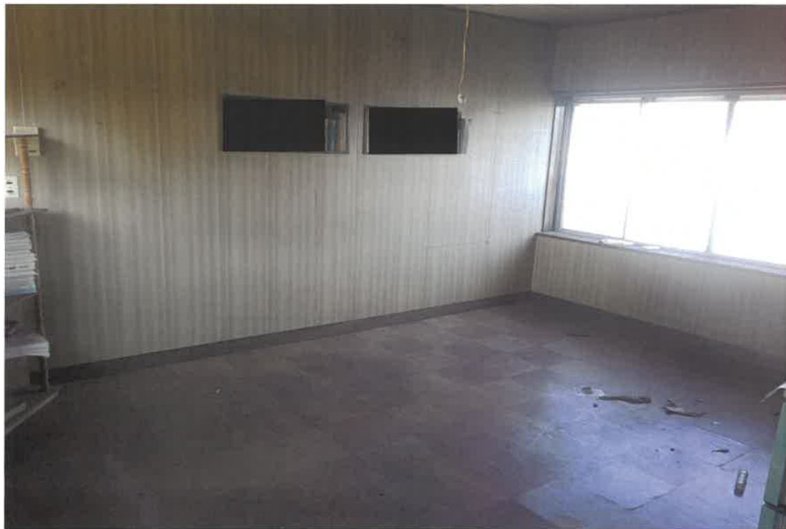
写真⑬(物件3 附属建物(符号1) 2階 リビングルーム)
