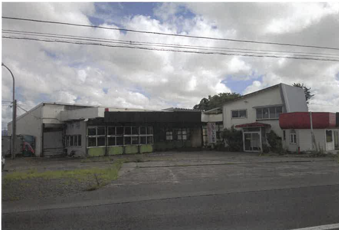
写真①(建物外観)
