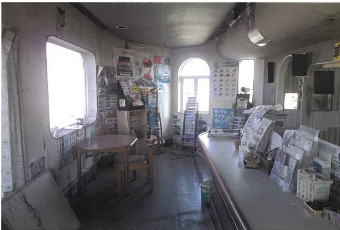
写真⑫(物件3 附属建物(符号1) 1階 事務所)
