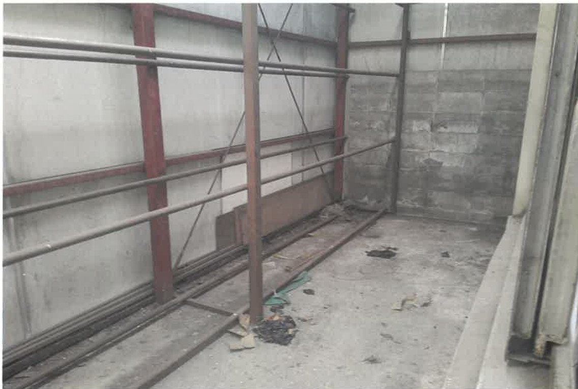
写真⑨(物件3 附属建物(符号2)内部)
