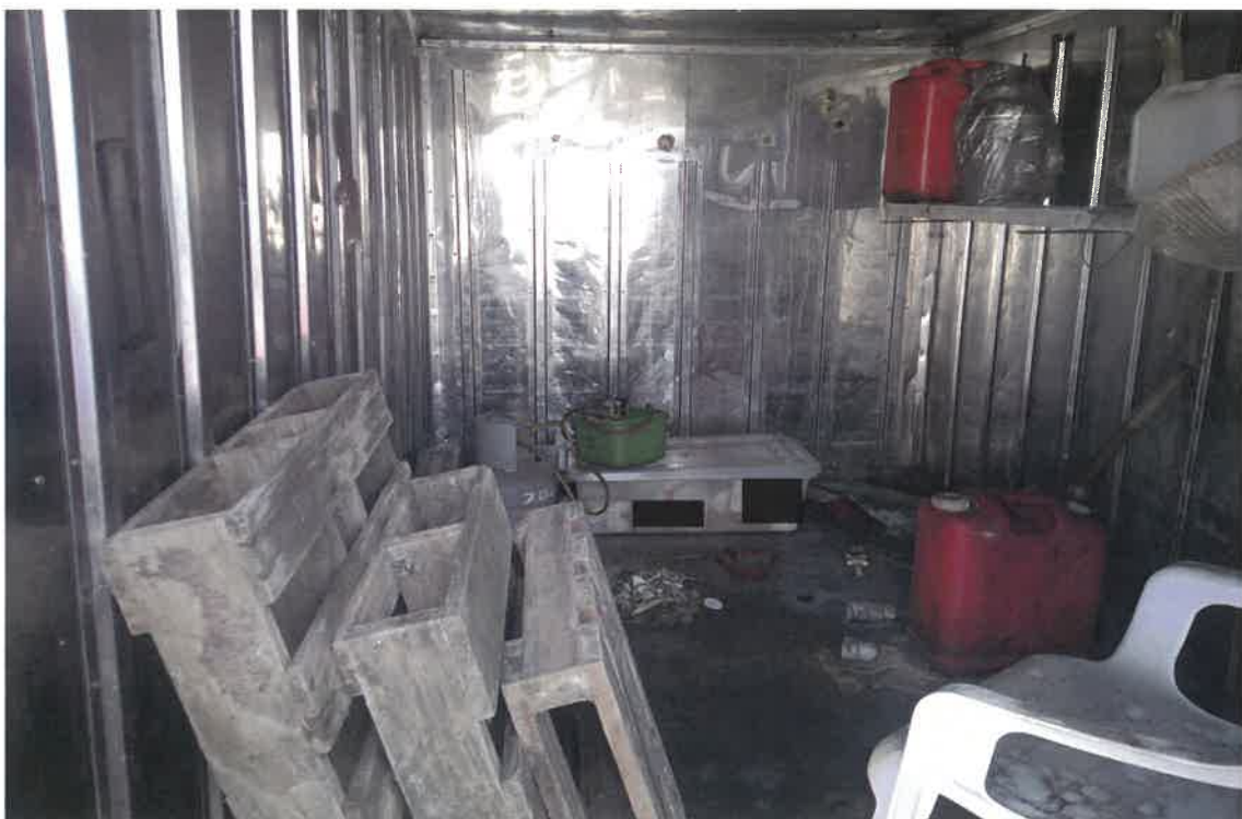
写真⑩(コンテナ内部)
