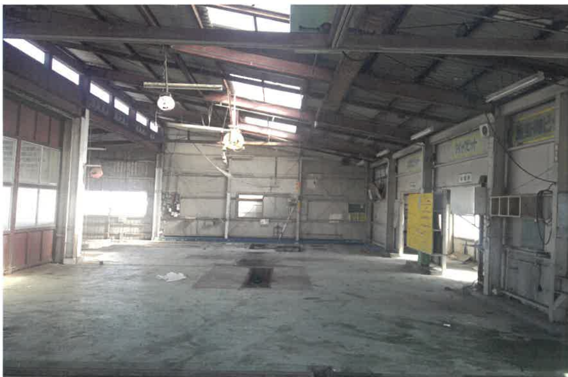
写真⑧(物件3 工場内部)
