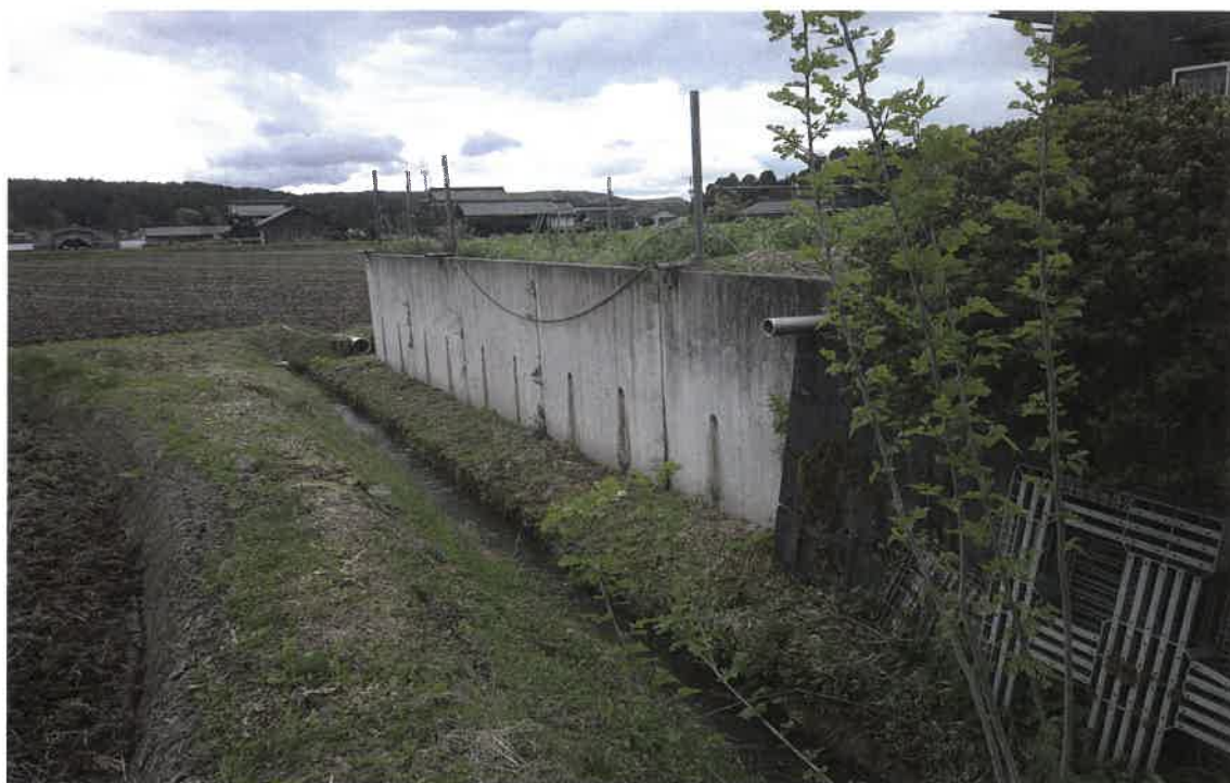
写真②(物件1 東側境界付近)
