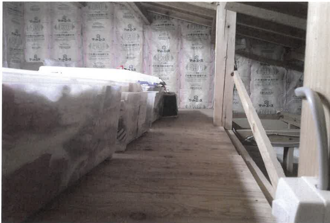
写真⑮(物件 2 2階 屋根裏収納)
