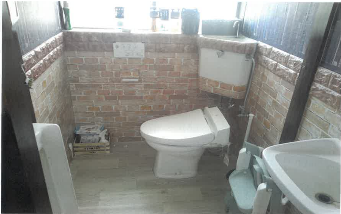
写真⑨(物件3 1階 トイレ)
