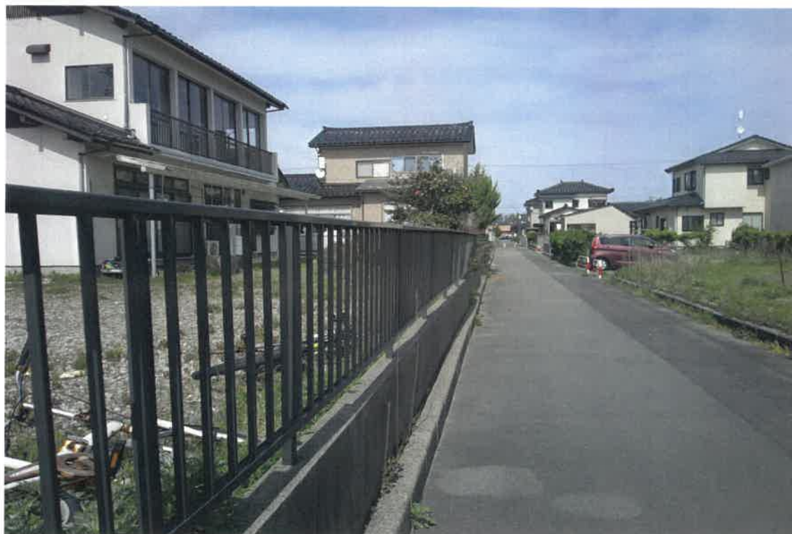
写真⑥(物件2 フェンスを撤去する前の南東側境界付近)
