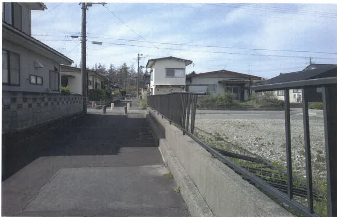
写真⑤(物件2 フェンスを撤去する前の南西側境界付近)
