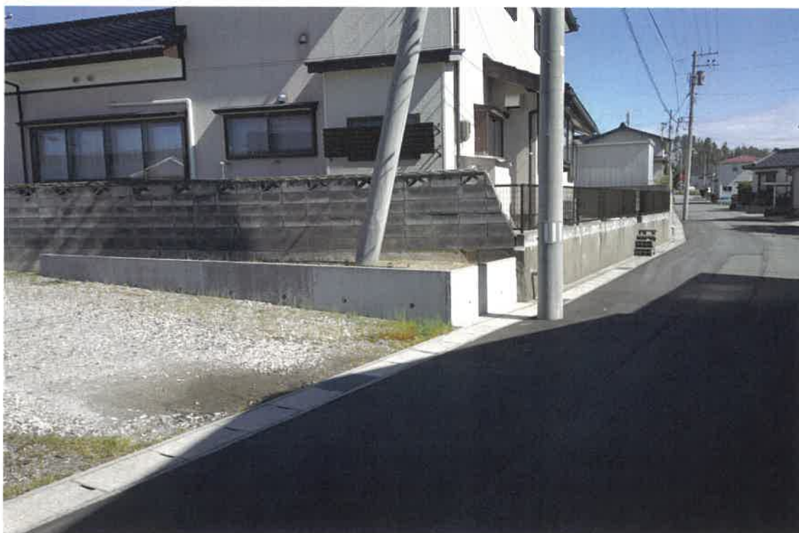
写真⑧(物件 2 西側角付近 電柱の本柱と支柱)
