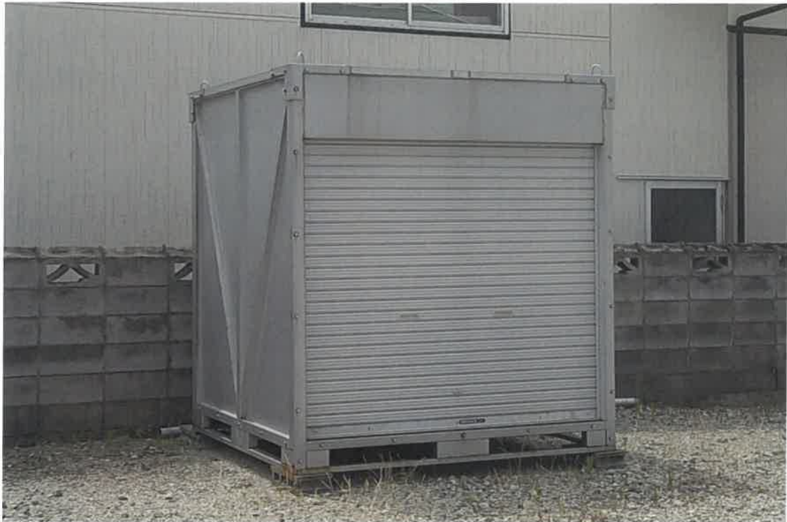
写真⑨(物件 2 仮設物置)
