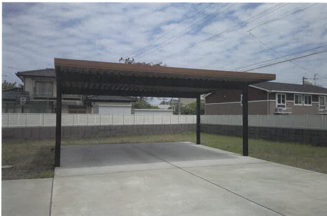
写真⑤(物件1 カーポート)
