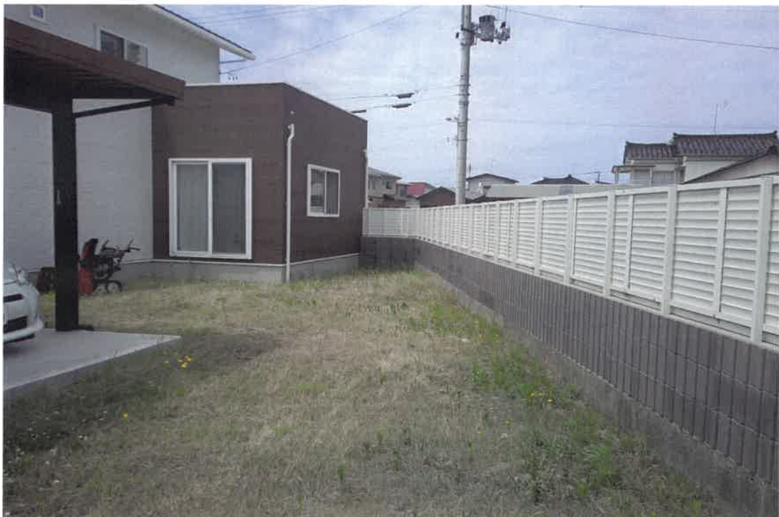
写真④(物件 1 北側境界付近)
