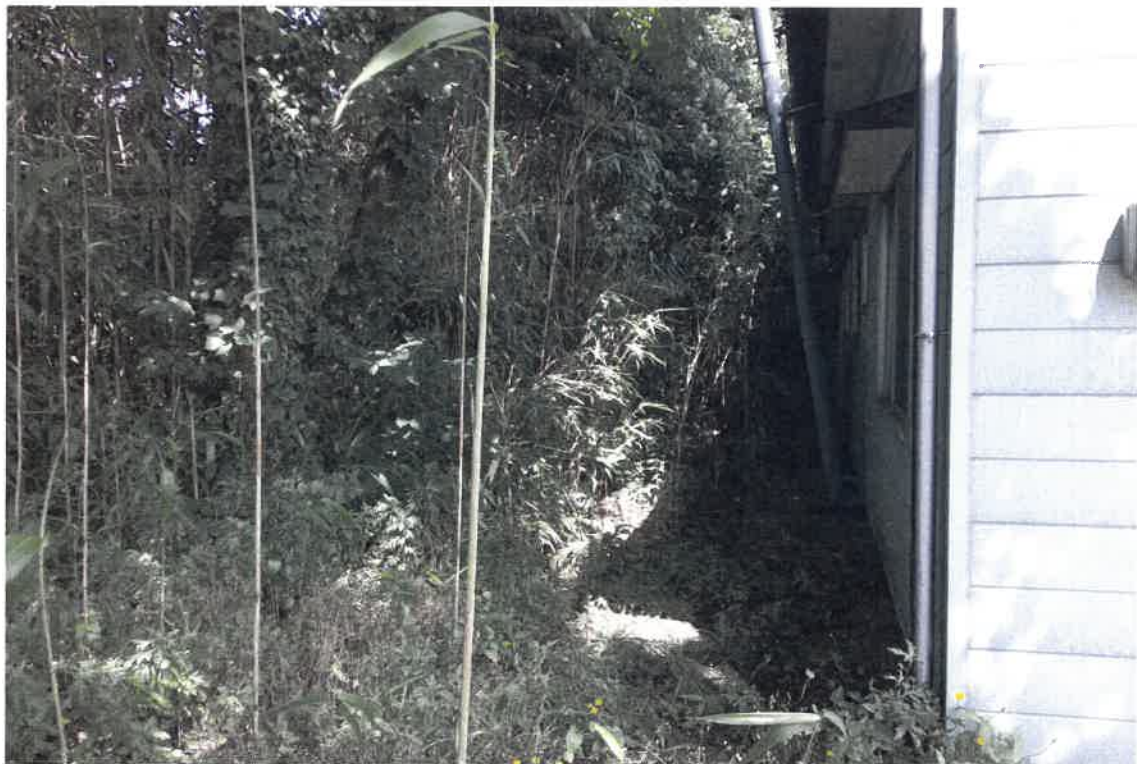
写真④(物件 1、2 北側境界付近)
