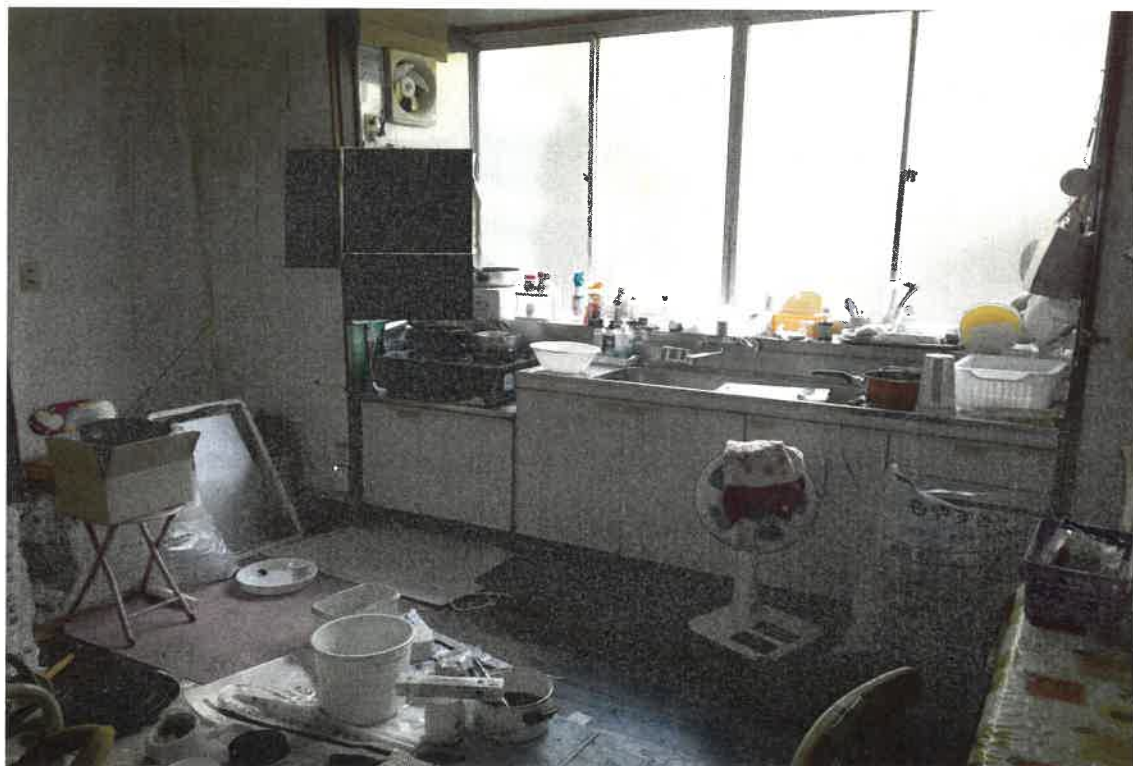
写真⑥(物件 3 1階 台所付近)
