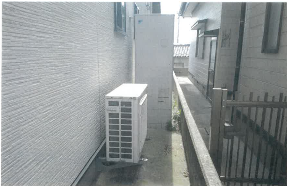
写真③(物件1 北側境界付近)
