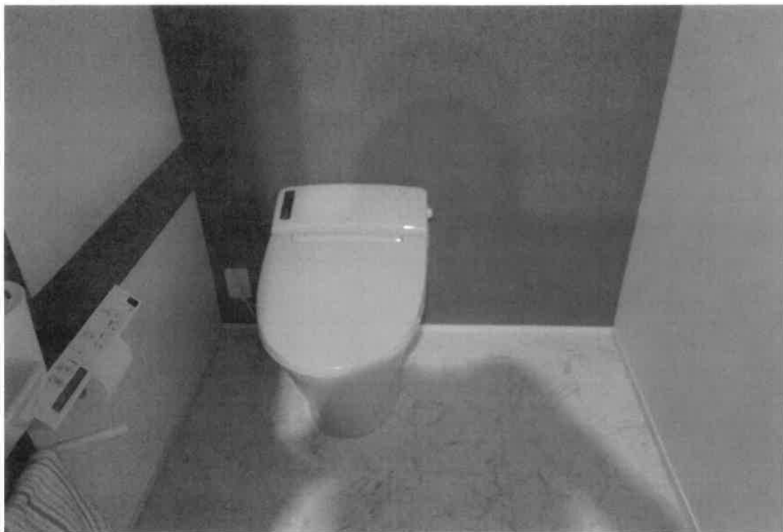
写真⑦(物件2 1階 トイレ)
