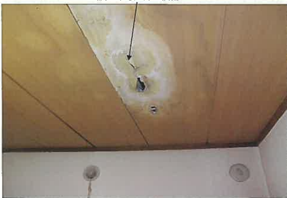
雨漏りによる天井の損傷
