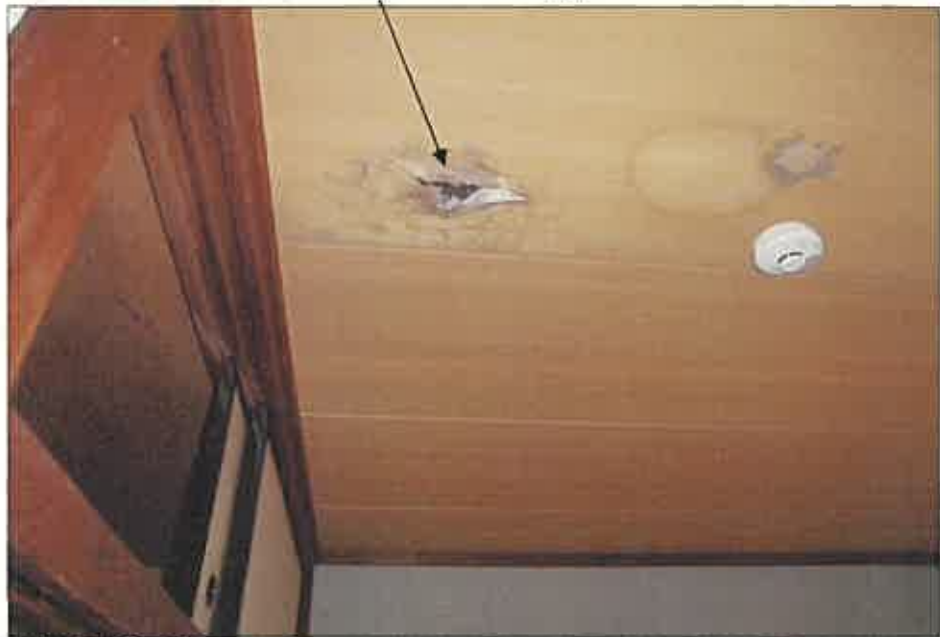
雨漏りによる天井の損傷
