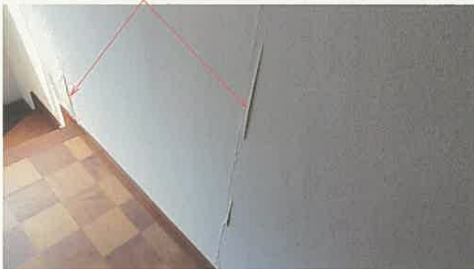
物件 2 建物内部の状況 (2 階)
