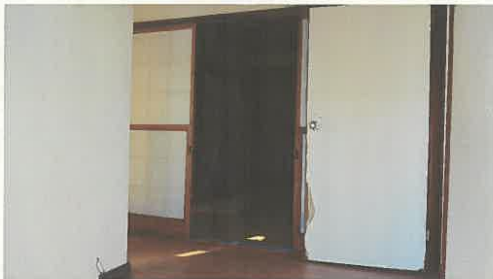
物件 2 建物内部の状況（1 階）
