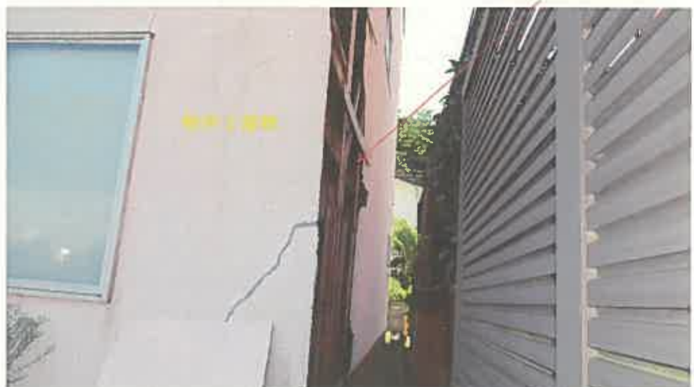
外壁が一部崩落している
