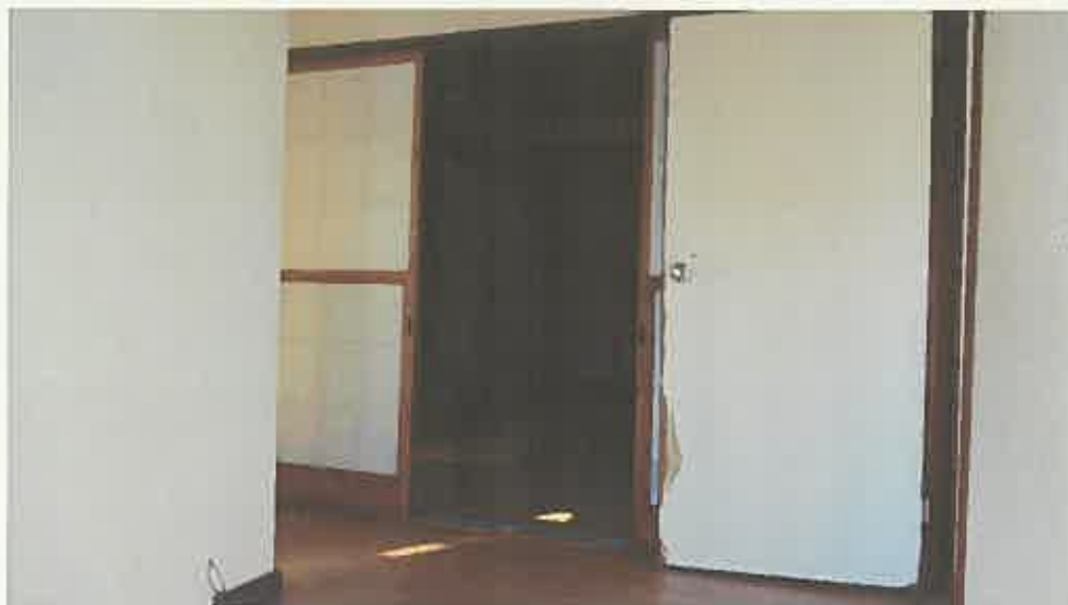
物件 2 建物内部の状況（1 階）
