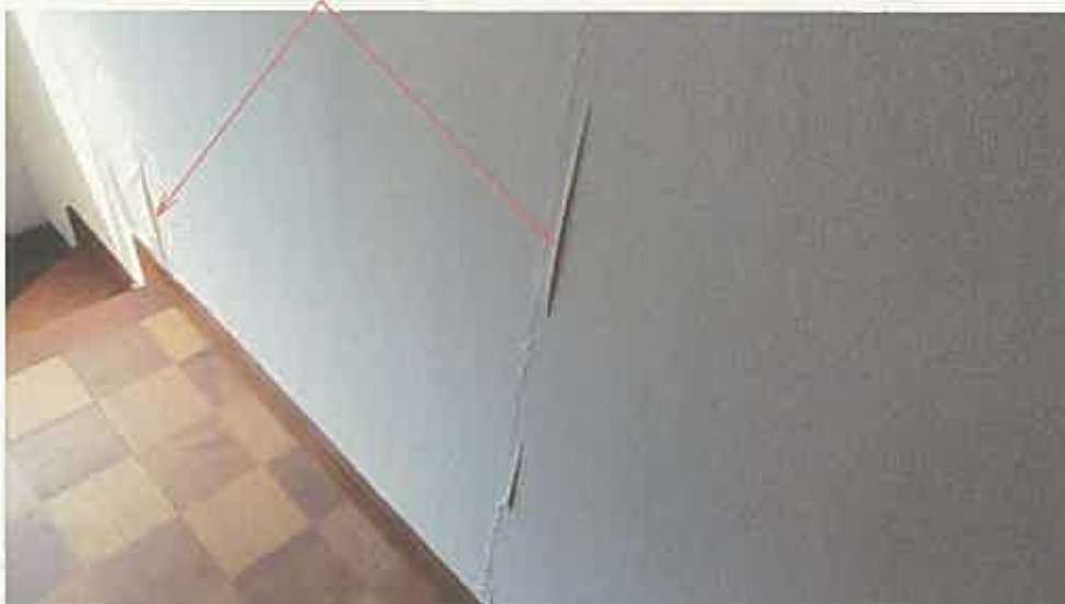
物件 2 建物内部の状況（2 階）
